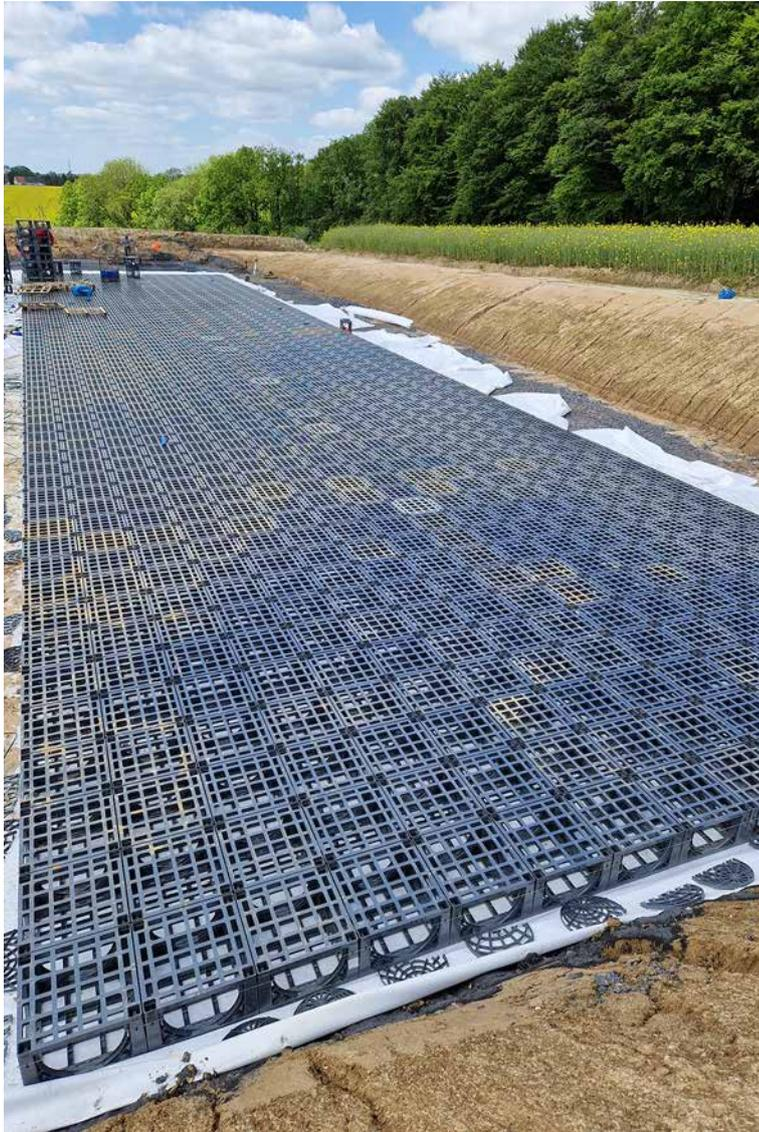
52,20 m lang und 9,6 m breit ist die Rigole, die im Neubaugebiet in Fröndenberg/ Ruhr für eine zuverlässige Regenwasserversickerung sorgen wird. Aufgrund des hohen Grundwasserstandes wurde die nur 33 cm hohe D-Raintank 3000 smallbox® eingesetzt.
