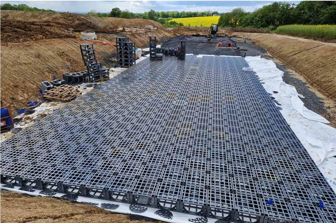
Die Kunststoffrigole hat eine geringere Breite als die eigentliche Sohlfläche der geplanten Versickerungsmulde. Aus diesem Grund werden die verbleibenden Seitenräume mit einem Rigolen-Kies 16/32 verfüllt, der ebenfalls mit Vlies ummantelt wird. Dadurch steht ein zusätzliches Rigolenvolumen zur Verfügung.
