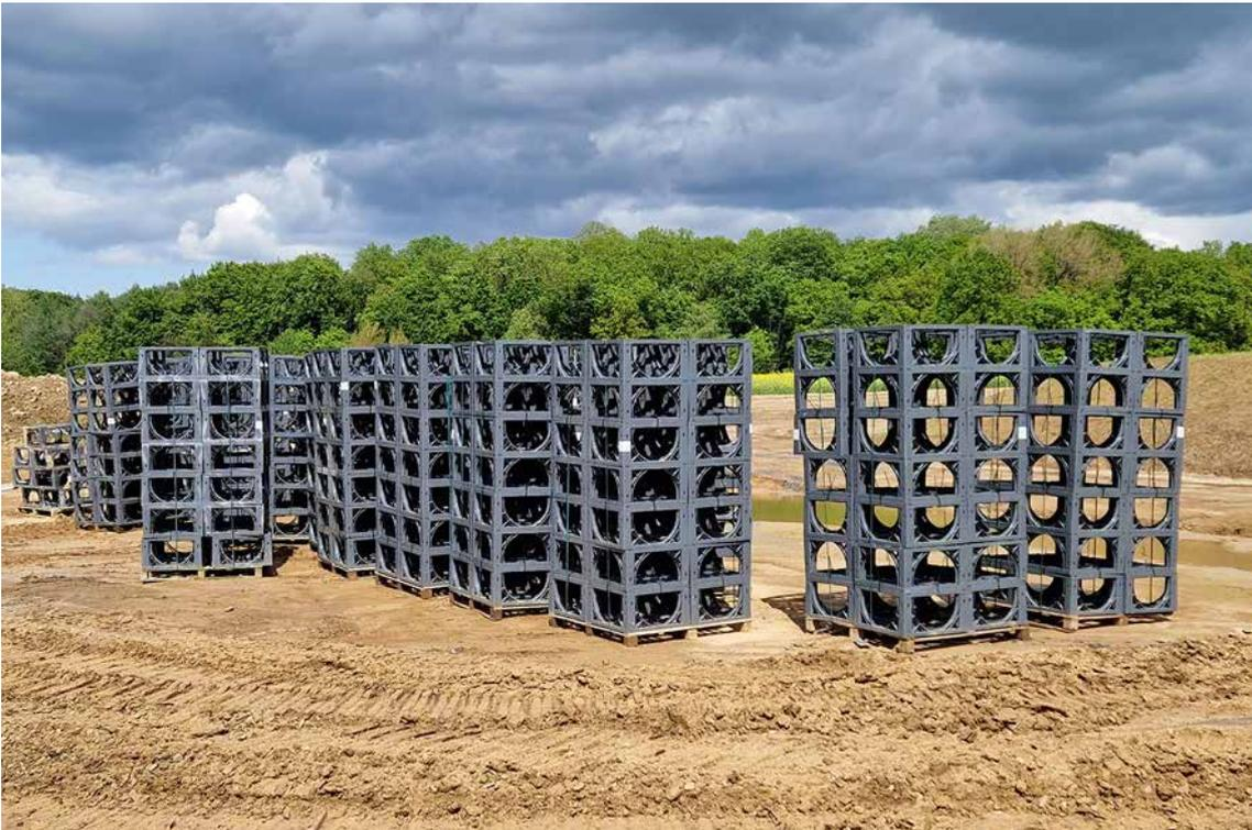
Effizient und platzsparend zugleich: Genau wie die Standardausführung der D-Raintank 3000®-Elemente überzeugt auch die flachere smallbox-Version mit einer Speicherfähigkeit von nahezu 97 %. Übliche Schotter- oder Kiesrigolen erreichen nur 30 % bis 35 %.
