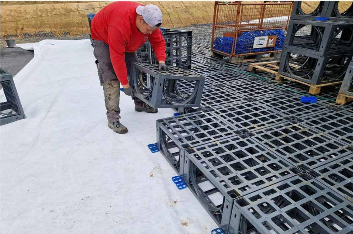
Keine 7,5 kg wiegt die D-Raintank 3000 smallbox®. Die einzelnen Rigolenelemente können daher schnell und leicht von einer Person von Hand verlegt werden.
