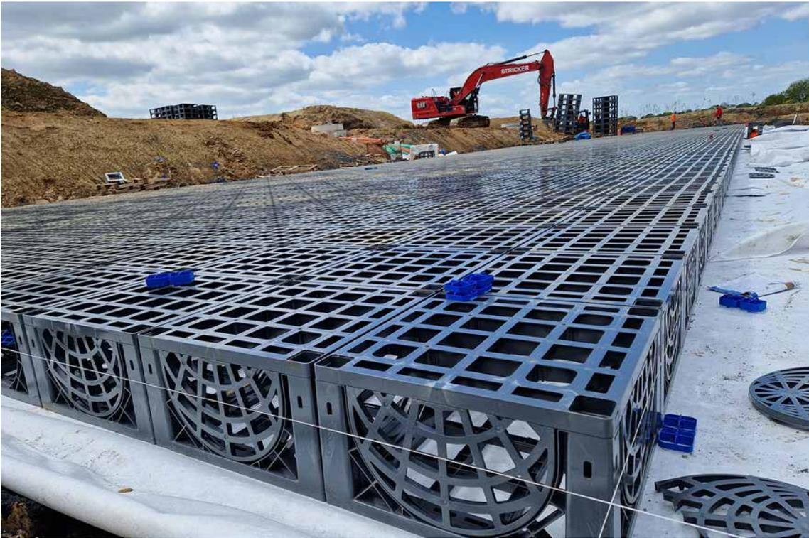
Die Außenseiten der Rigole werden mit speziellen gerasterten Seitenplatten versehen. Im Rigoleninneren sind keine Seitenplatten erforderlich.
