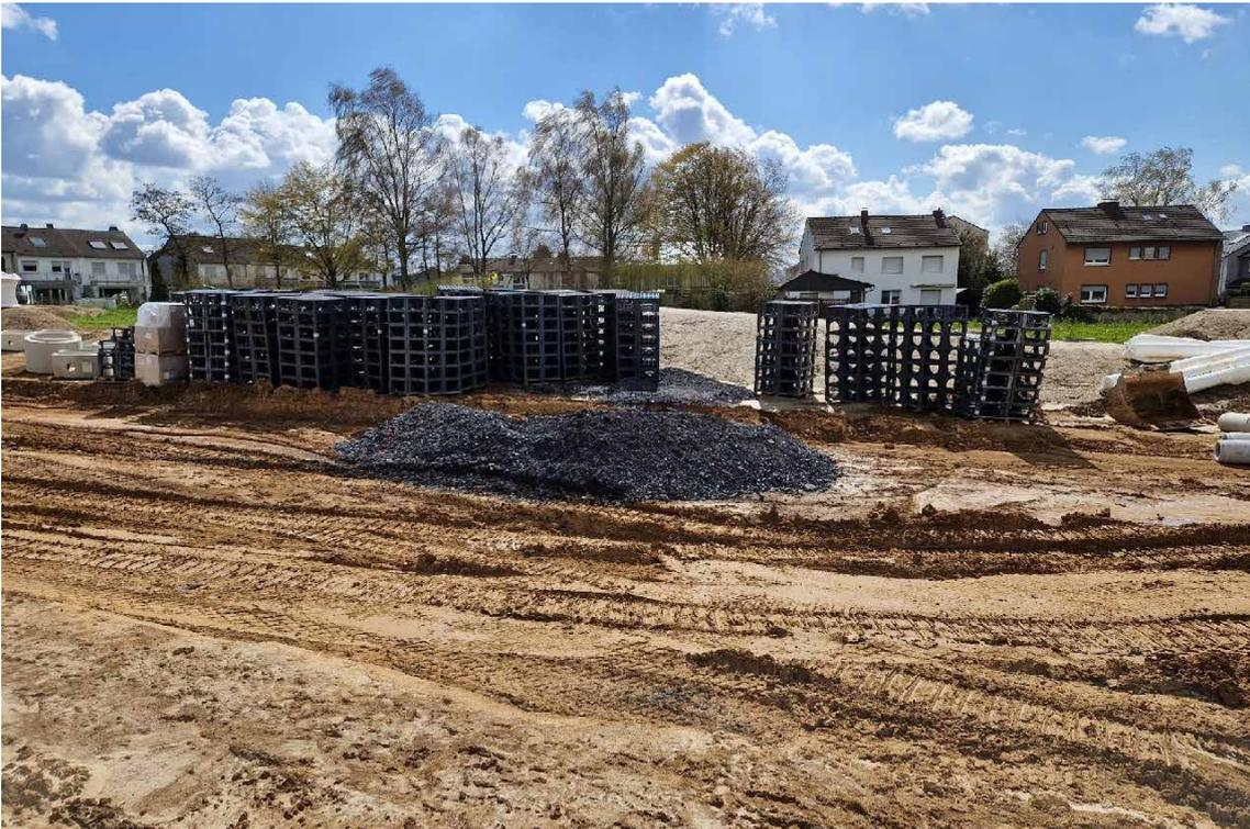
Bereit zum Einbau: Die einzelnen Elemente aus widerstandsfähigem PVC-U werden einbaufertig auf die Baustelle geliefert.
