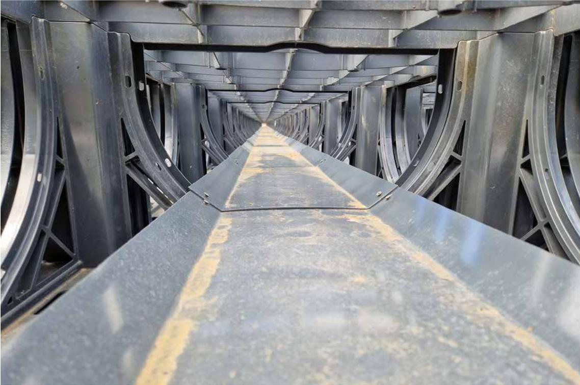
Die Rigole aus D-Raintank 3000 smallbox®-Elementen wurde mit speziellen Inspektionstanks ausgestattet. Sie verfügen über eine Schiene, die auch den Einsatz von Fahrwagenkameras mit kleinen Rädern ermöglicht.
