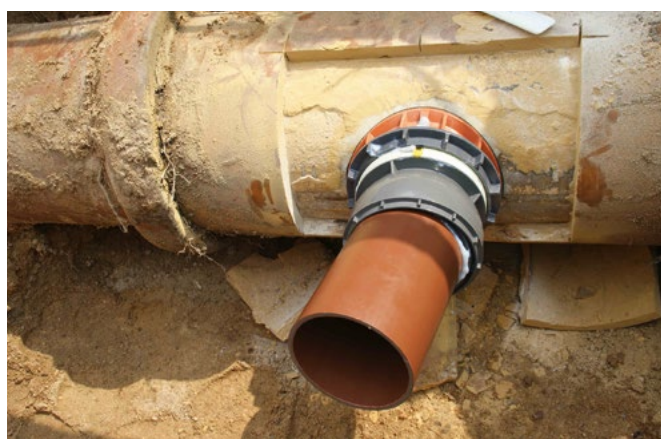
Der Einbau des Liner-Anschlusses System CONNEX: Über eine Öffnung im Distanzring wird die Dichtmasse eingeführt.
