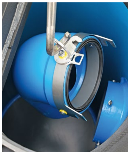
Mit einer Drehung um 45° wird die Verschlusslasche entriegelt.
