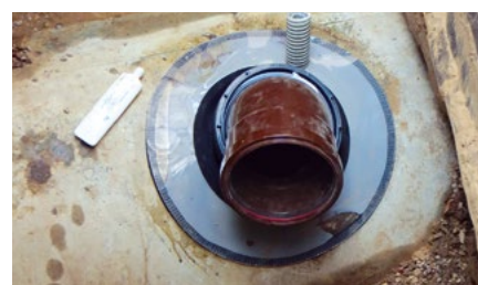
Ein spezielles Vergussharz sorgt für die Herstellung einer dichten Verbindung.
