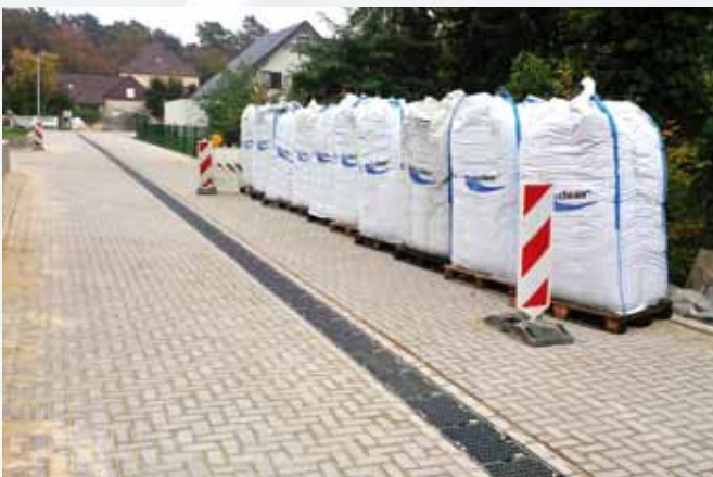
Mit dem Lkw befahrbar: Die Mulde mit der Gussabdeckung Klasse D 400.
