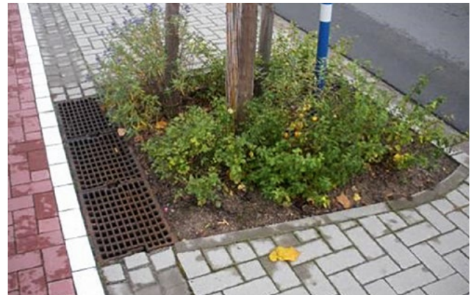
Über eine mit Substrat gefüllte D-Rainclean®-Sickermulde gelangt gereinigtes Niederschlagswasser zur Bewässerung in die Baumscheibe zum Wurzelballen
