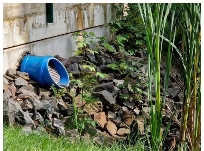
Auslaufstück mit Froschkappe, Übergabepunkt ins öffentliche Gewässer
