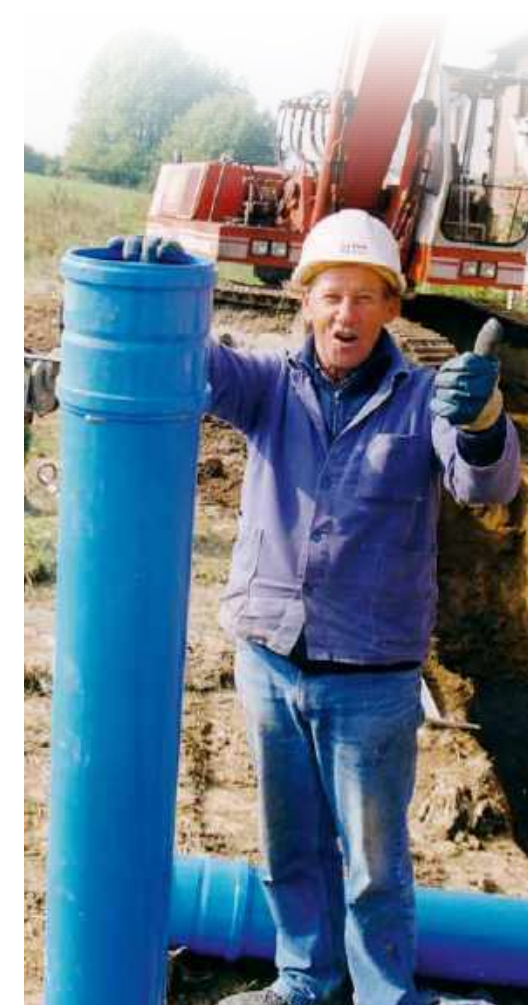
Eine der ersten Baumaßnahmen mit HS®-Rohren ist gut gelaufen.
