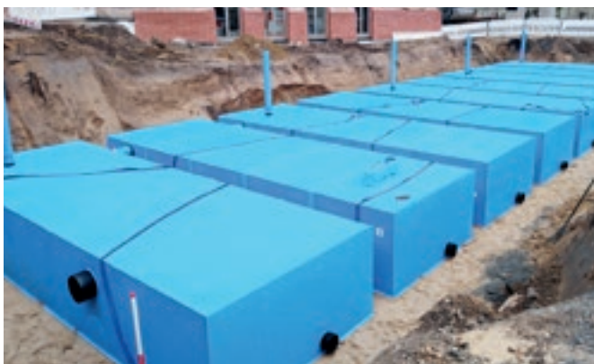
Verschiedene KS-Bluebox®-Elemente können an der Einbaustelle miteinander verbunden werden.
