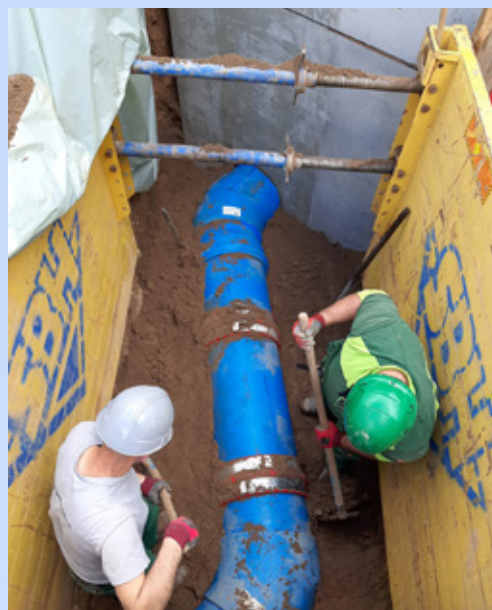
Das Funke Pipe2Pipe®-Kanalrohrsystem umfasst auch Formteile, wie die hier im Bild zu sehenden Bögen. Ebenfalls zum Einsatz kommen in Heidelberg VPC®-Rohrkupplungen von Funke.
