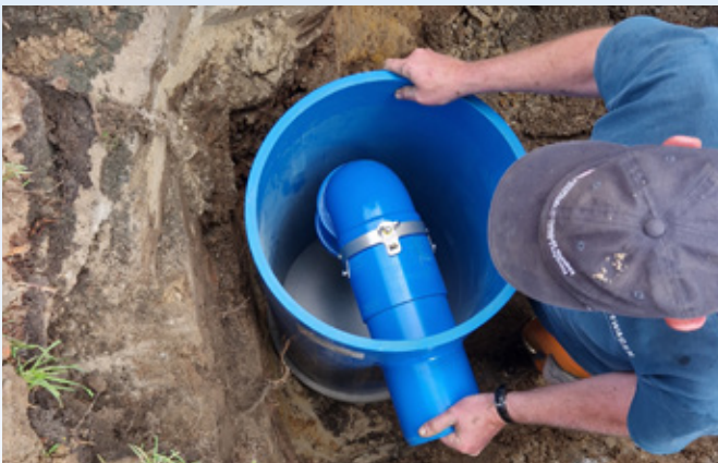
Funke Straßenaufbau mit Funke Schnellkupplung® und Tauchbogen
