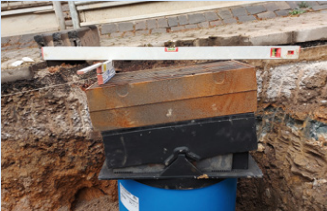
Dank der Auflagebacken und Ausgleichsringe kann das benötigte Höhen- und Neigungsniveau perfekt eingestellt werden.
