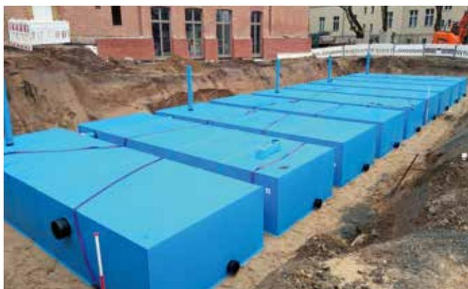
Bereithaltung von Löschwasser geht. Vor diesem Hintergrund wurde die KS-Bluebox® entwickelt. Sie besteht aus werkseitig kunststoffummantelten D-Raintank 3000®-Elementen. Die KS-Bluebox® eignet sich nicht nur für die Zwischenspeicherung von Regenwasser, sondern – mit Blick auf eine spätere Entnahme und Nutzung – auch für eine dauerhafte Speicherung.
