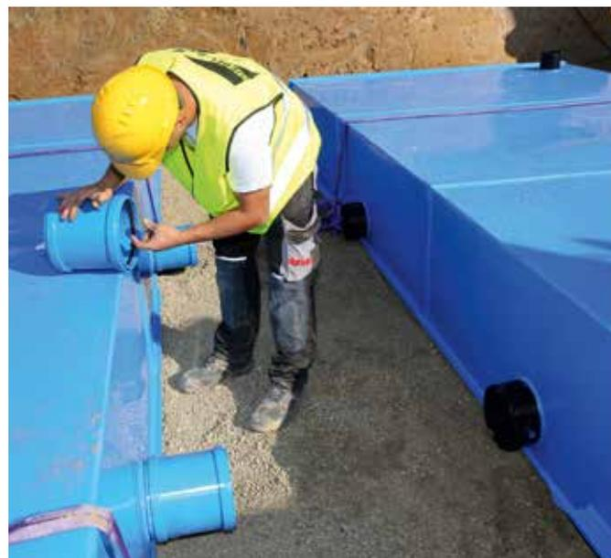
box® sind zwingend Entlüftungen vorzusehen. Diese können entweder über Inspektionsblöcke mit Entlüftungen in der Gussabdeckung oder über Entlüftungsanschlüsse realisiert werden. Je nach Belastung stehen als Muldenentlüftung verschiedene Abdeckungen zur Verfügung. Zur Spülung und Kamerabefahrung können auf Wunsch Inspektionsblöcke und Inspektionstanks integriert werden.
