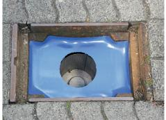
Die Passform der Adapterplatte nach jedem Schneidvorgang erproben und gegebenfalls korrigieren.
