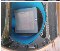
Anschließend wird das Leitelement auf das geöffnete Rohrstück (roter Pfeil) gesetzt.
