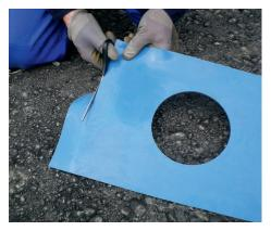
Die Adapterplatte entsprechend der Geometrie des Aufsatzes/der Gussabdeckung mit einer Schere zuschneiden. In einem ersten Schritt wird nur die rechteckige Form des Aufsatzes ausgeschnitten. Für den Zuschnitt der Details wird iterativ vorgegangen, sodass immer nur ein kleiner Teil weggeschnitten wird. Niemals zu viel in einem Arbeitsgang abschneiden!
