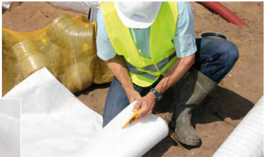
Zuschnitt des Filtervlieses mit dem Funke Filtervlieschneider
