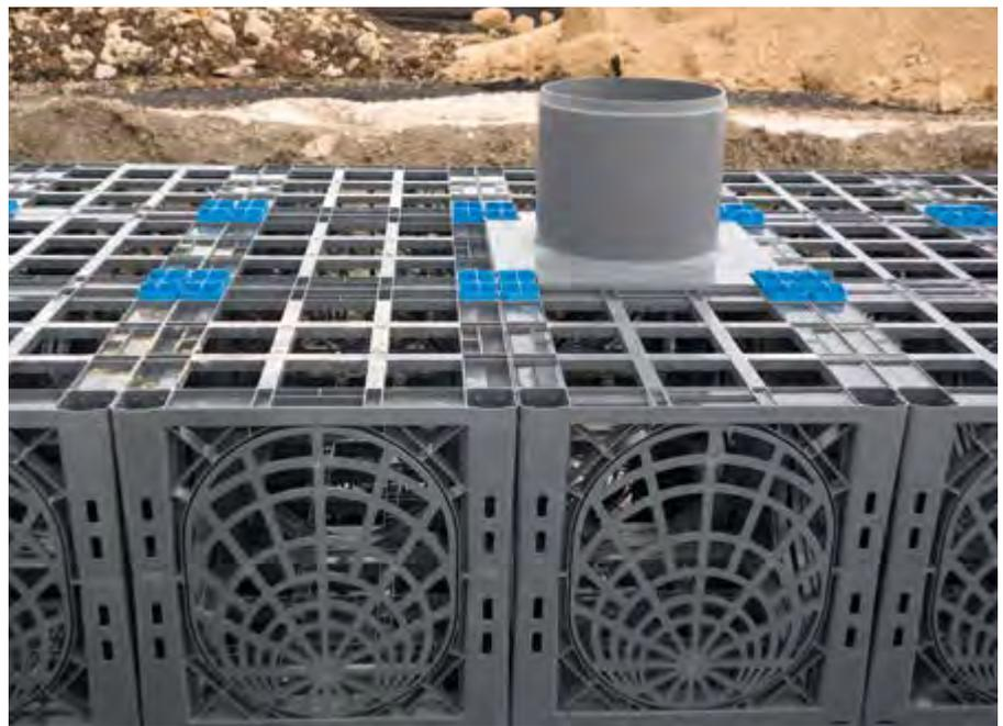
> *Inspektionsblock mit Steigrohranschluss DN 400 zur Wartung*
