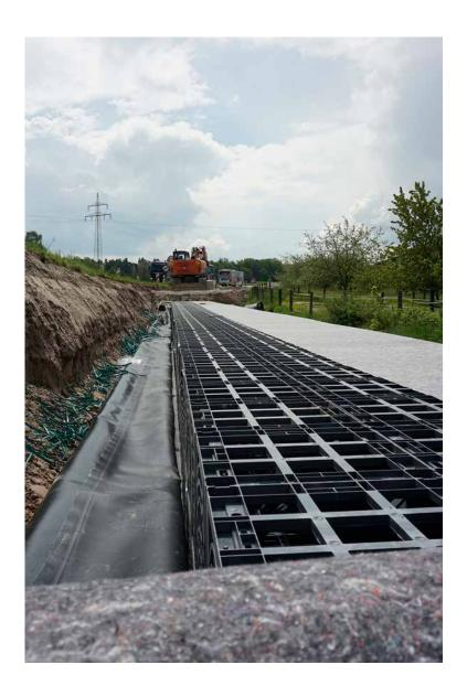
Der Retentionskörper wird zuerst mit einem Filtervlies, dann mit der vorgesehenen Kunststoffdichtungsbahn und abschließend noch einmal mit einem Filtervlies ummantelt.
