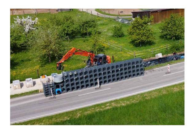
Vor dem Einbau wurden die D-Raintank 3000®-Elemente vor Ort zwischengelagert. Auf der linken Seite ist das profilierte Schachtrohr DN 1000 zu sehen. Es sitzt auf vier miteinander verschweißten D-Raintank-3000®- Elementen und bietet ein großzügiges Platzangebot für einen Einstieg in den Retentionskörper inklusive des integrierten Drosselablaufs.
