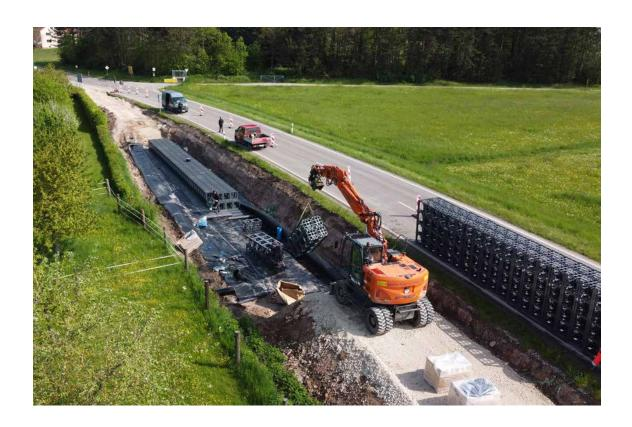
Nach dem Lückenschluss im Radwegenetz zwischen Gerersdorf und Niederoberbach sorgt in Zukunft ein knapp 111 m³ fassender Retentionsblock aus D-Raintank 3000®-Elemente von Funke Kunststoffe für die kontrollierte Ableitung des Niederschlagswassers in den Hesselbach.
