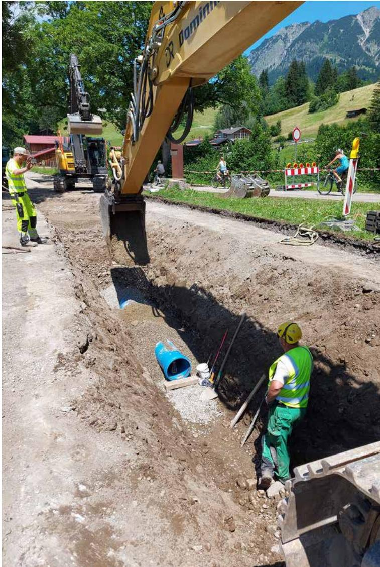
Der Bereich der Rohrleitungszone ist beiderseits der Rohrleitung in gleichmäßigen Lagen zu verfüllen und zu verdichten.
