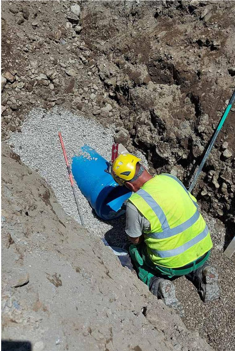
Einfache Handhabung: Rohre und Formteile sind mit einer fest eingelegten Dichtung ausgestattet – das schließt aus, dass die Dichtung fehlerhaft eingebaut oder gar komplett vergessen wird.
