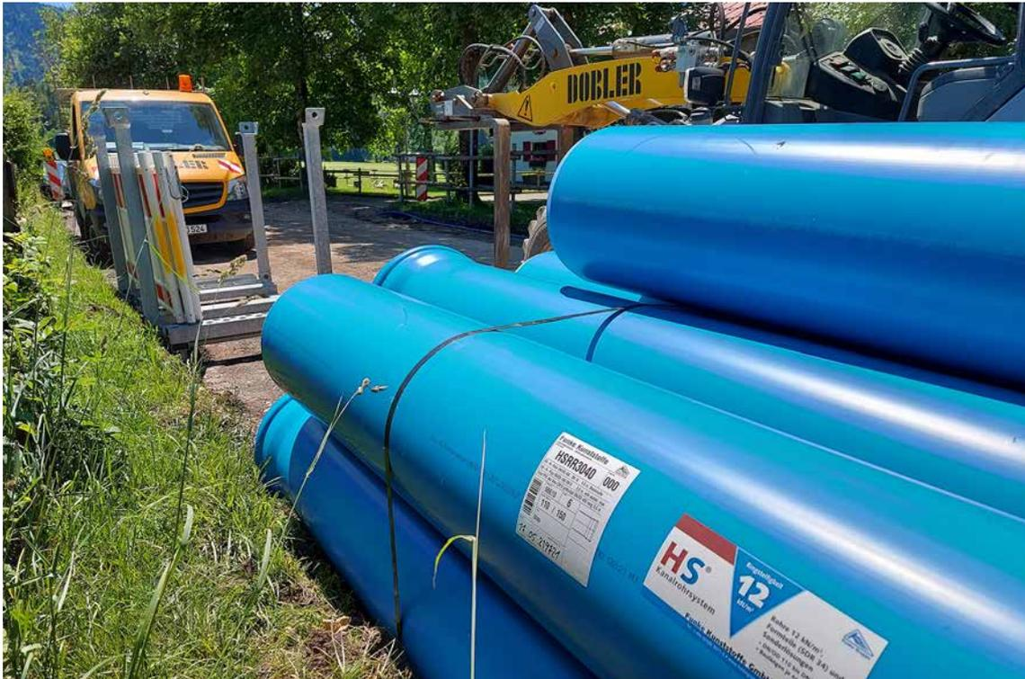
HS®-Kanalrohre sind zugelassen vom Deutschen Institut für Bautechnik (DIBt-Zulassung Z.-42.1-309). Dabei handelt es sich um wandverstärkte Vollwandrohre aus PVC-U, hergestellt in Anlehnung an die DIN EN 1401-1 und mit einer Mindestringsteifigkeit von 12 kN/m<sup>2</sup> (SN 12) bzw. 16 kN/m<sup>2</sup> (SN 16).
