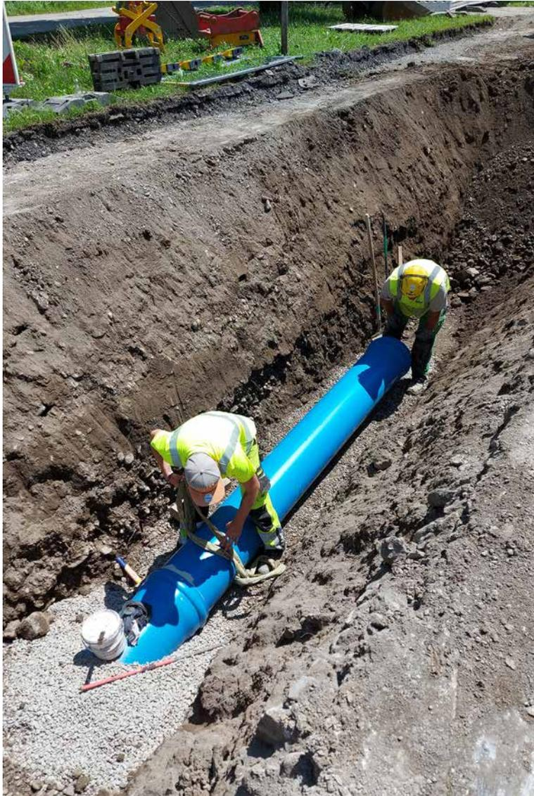
Die Rohre, die in der Nennweite DN/OD 400 über eine angeformte Muffe verfügen, sorgen für mehr Flexibilität auf der Baustelle und trugen zum schnellen Baufortschritt bei.
