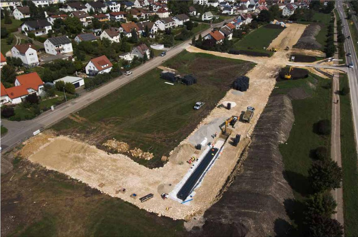
Ein Rigolensystem aus D-Raintank 3000®-Elementen wird das Neubaugebiet in Oberelchingen gegen Überflutungen schützen.
