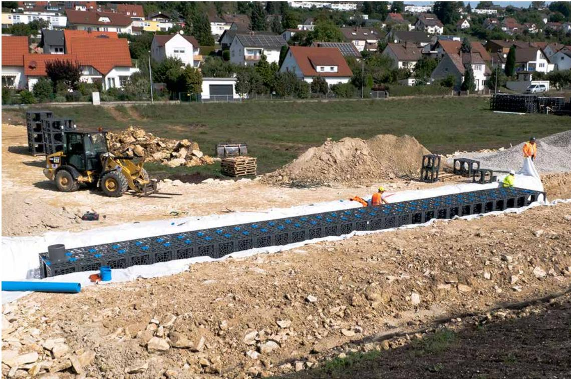
Eine Rigole aus D-Raintank 3000®-Elementen wird mit einem speziellen Filtervlies sanddicht ummantelt.
