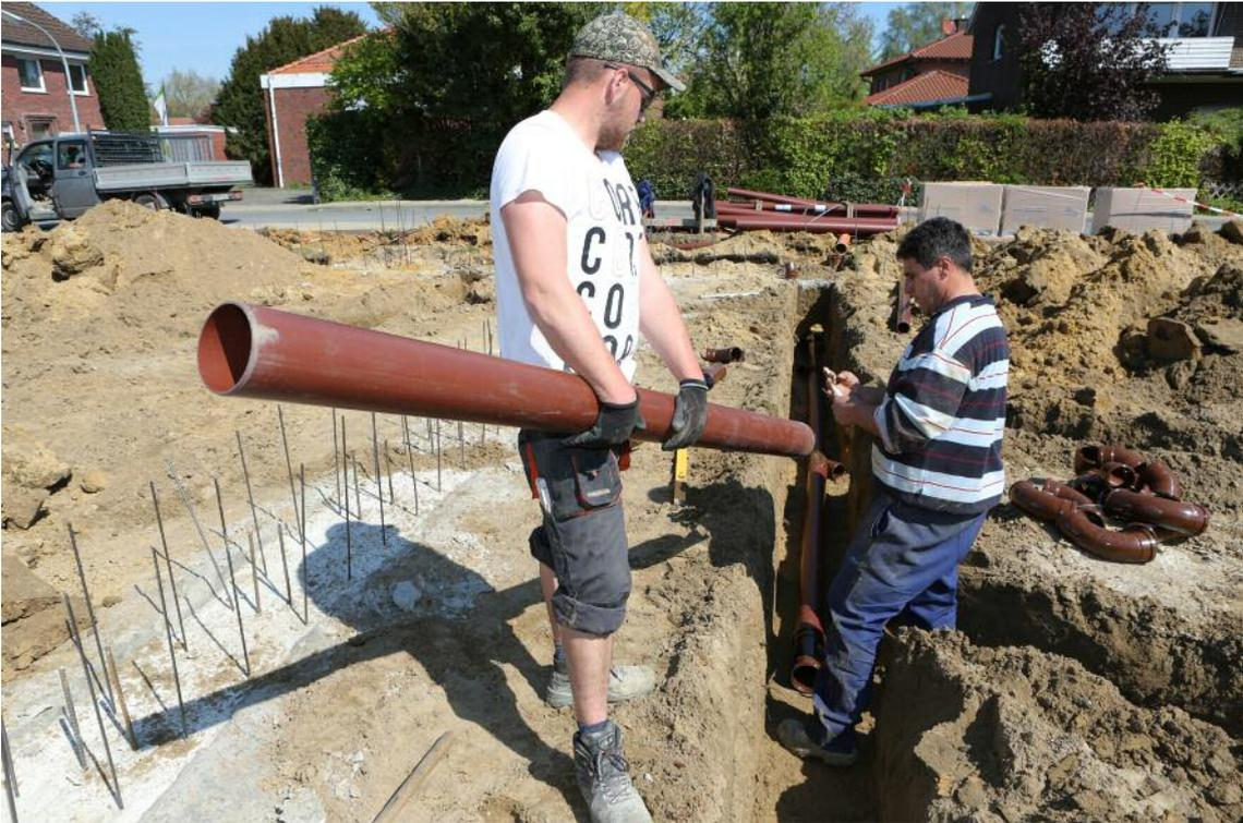
Geringes Gewicht und muffenlos gefertigte Rohre machen die Verlegung des HS<sup>®</sup>-Kanalrohrsystems ebenso einfach wie Formteile mit fest eingelegten Dichtungen.
