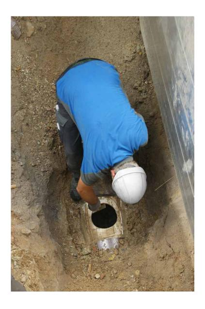
Die Bohrung für den Liner-Anschluss System CONNEX wurde fachgerecht hergestellt.
