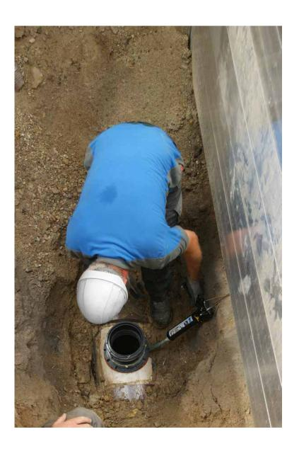
Der Einbau des Liner-Anschlusses System CONNEX: über eine Öffnung im Distanzring wird die Dichtmasse eingeführt.
