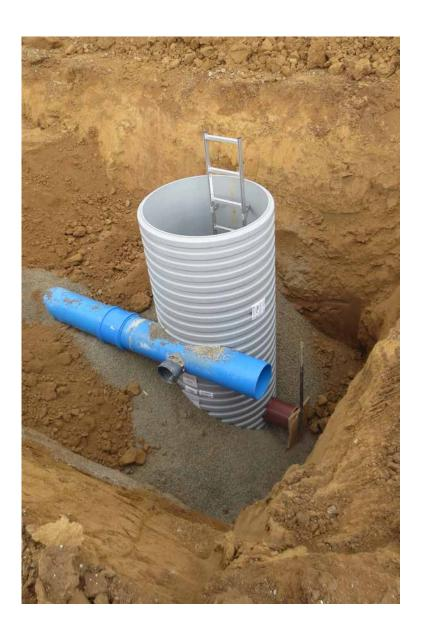
Der Funke Kunststoffschacht DN 1000 wird werkseitig vormontiert mit einer Steigleiter aus Edelstahl auf die Baustelle geliefert.
