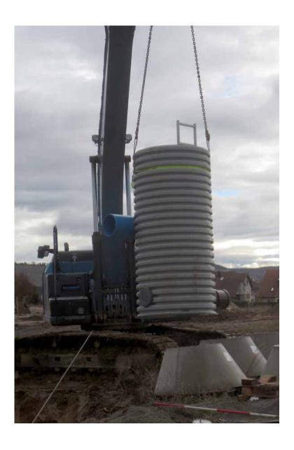
Die Funke Kunststoffschächte DN 1000 werden mit einem speziellen Verlegegurt für den Transport auf der Baustelle und das Setzen geliefert.
