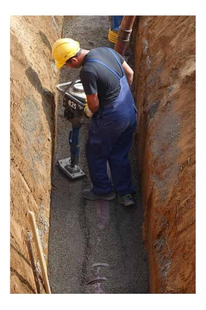
Die fachgerechte Verdichtung der Leitungszone erfolgt mit Hilfe eines Vibrationsstampfers.
