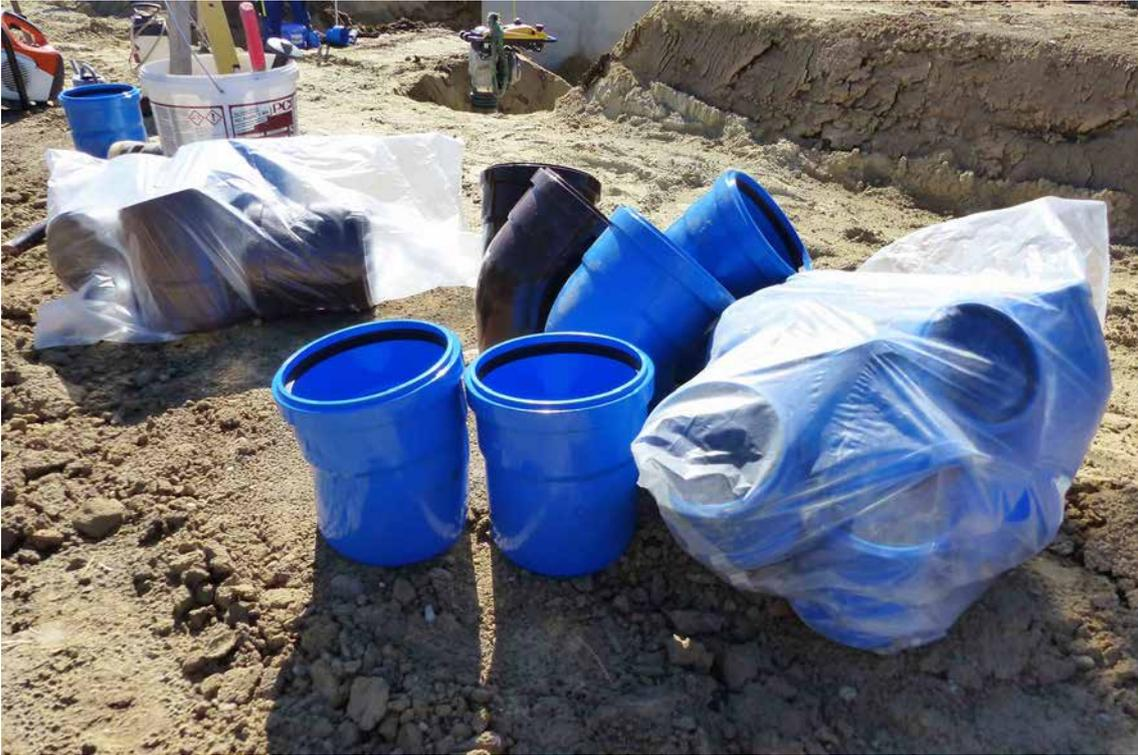
Das HS®-Kanalrohrsystem ist mit einer großen Zahl von Formteilen für die unterschiedlichsten Anwendungsbereiche ausgestattet. Sie sind ebenso wie die anderen Bauteile wandverstärkt.
