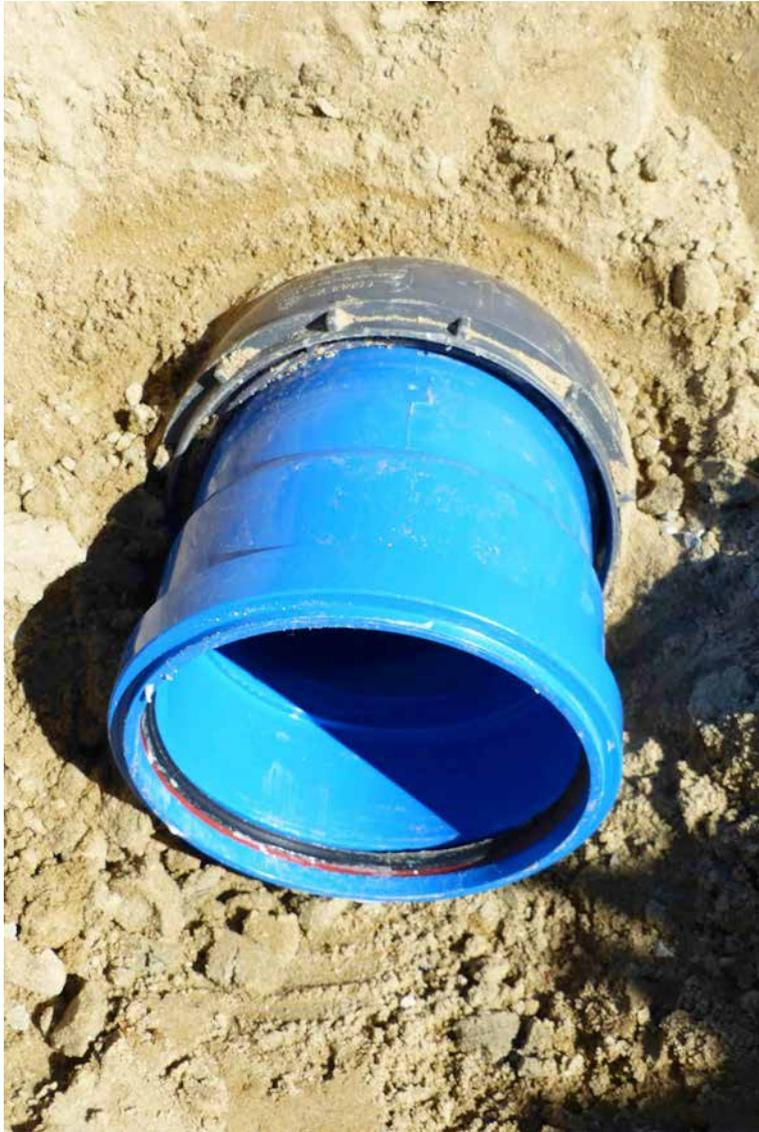
Der Einsatz von CONNEX-Anschlüssen sorgt für eine erhöhte Flexibilität und trägt dazu bei, dass die Verbindungen dauerhaft dicht und intakt bleiben.
