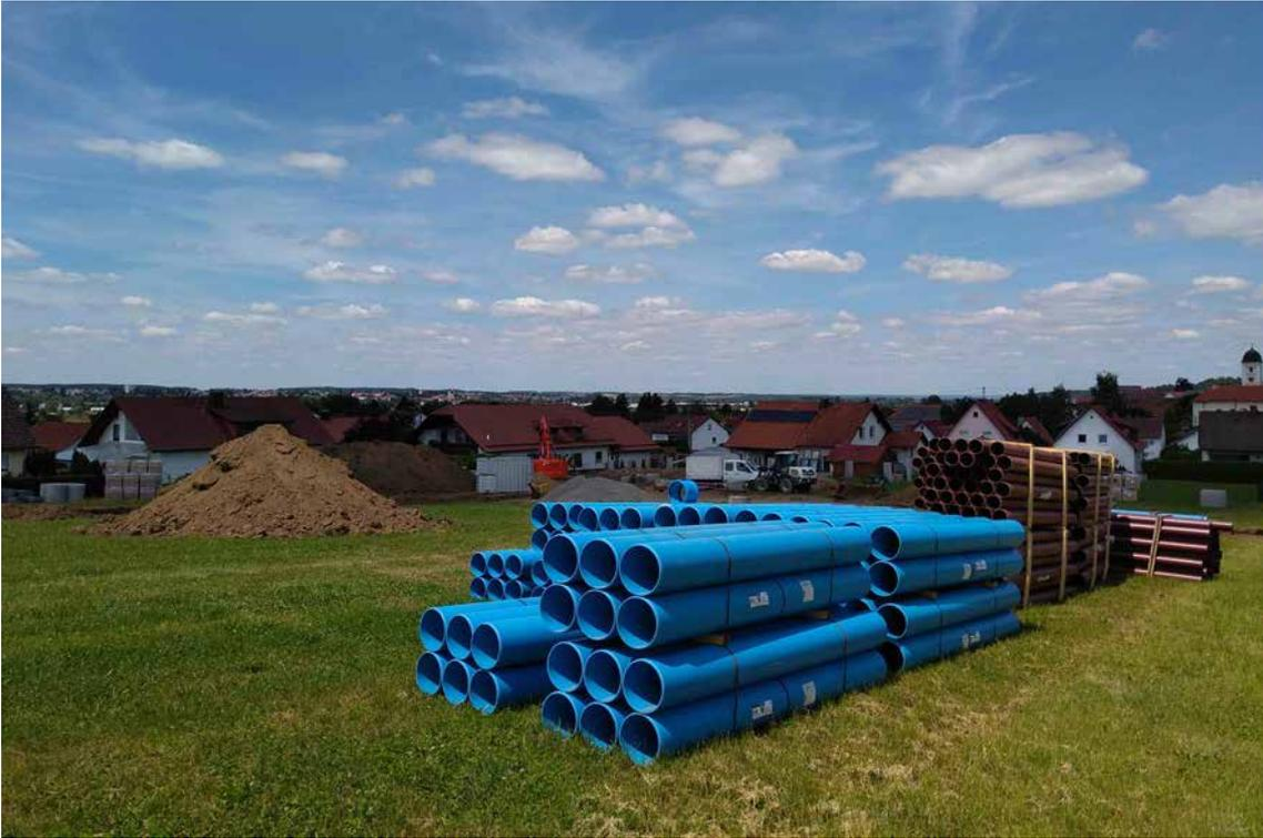
Die bayerische Gemeinde Röfingen entwässert im Trennsystem. Die farbliche Unterscheidung der HS®-Kanalrohre von blau für Regenwasser und braun für Schmutzwasser ist daher bei den Erschließungsarbeiten im Baugebiet Kirlesberg Ost von Vorteil.
