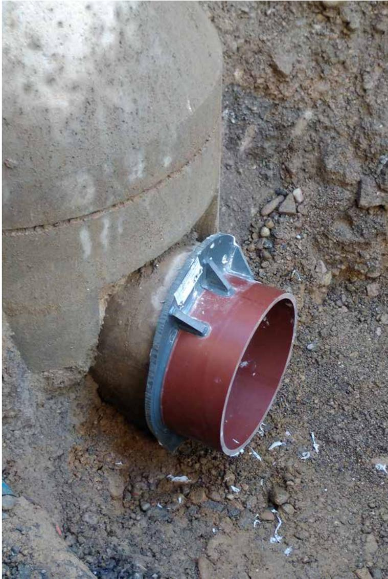
Eingebauter Eiprofiladapter. Eine VPC®-Rohrkupplung sorgt für eine dichte Verbindung mit dem nächsten Rohr.
