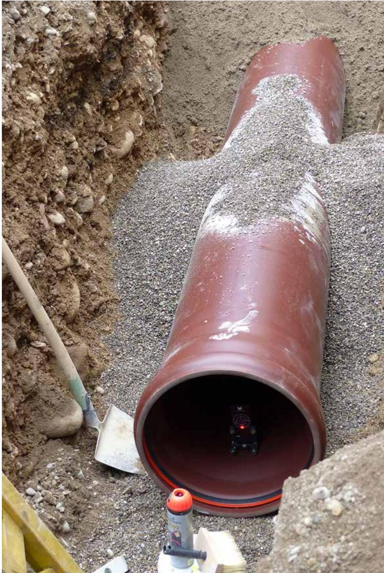
Alle Bauteile des Kanalrohrsystems sind mit einer fest integrierten FE®-Dichtung ausgestattet.
