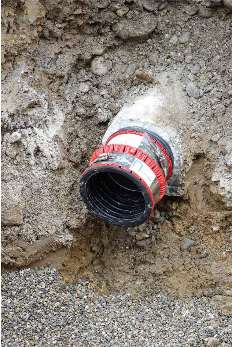
Eine perfekte Kombination: Mit BI-Adapter und VPC®-Rohrkupplung lassen auch dauerhaft dichte Verbindungen zu Rohren schaffen, die nur innen kreisrund sind.
