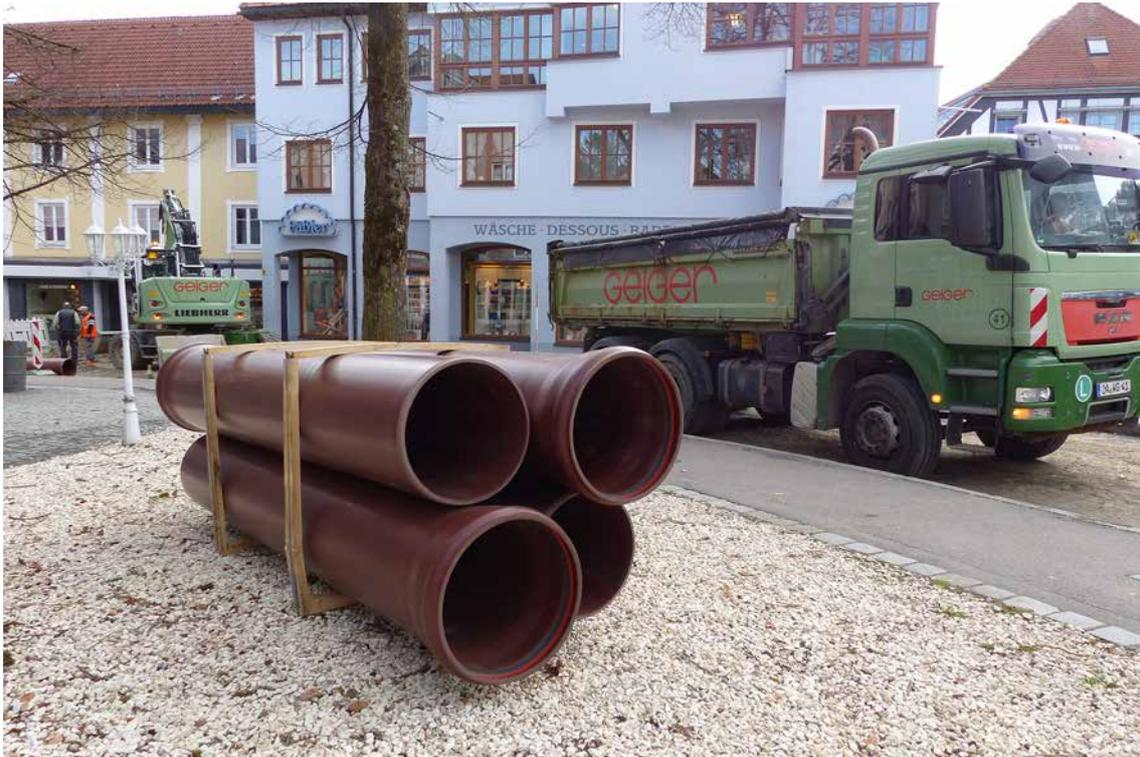
Für die Erneuerung des Mischwasserkanals in der Bahnhofstraße in Immenstadt kamen braune HS®-Kanalrohre zum Einsatz.
