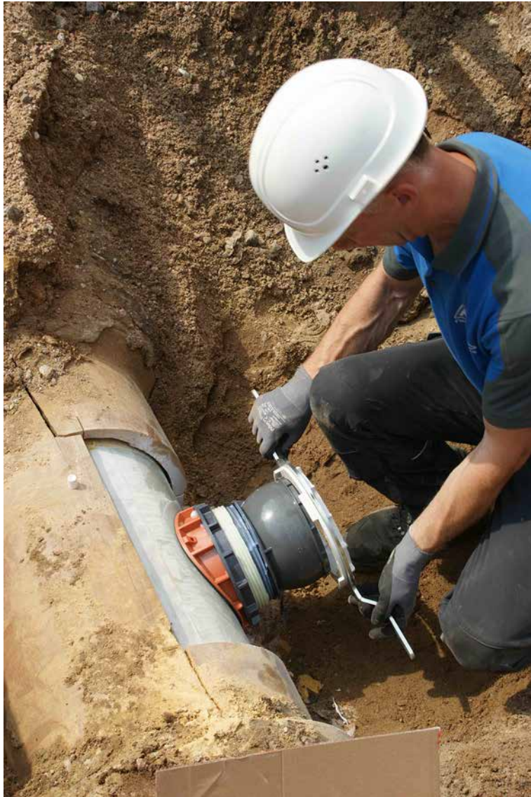
Einfach: Die Montage des Liner-Anschlusses System CON-NEX.
