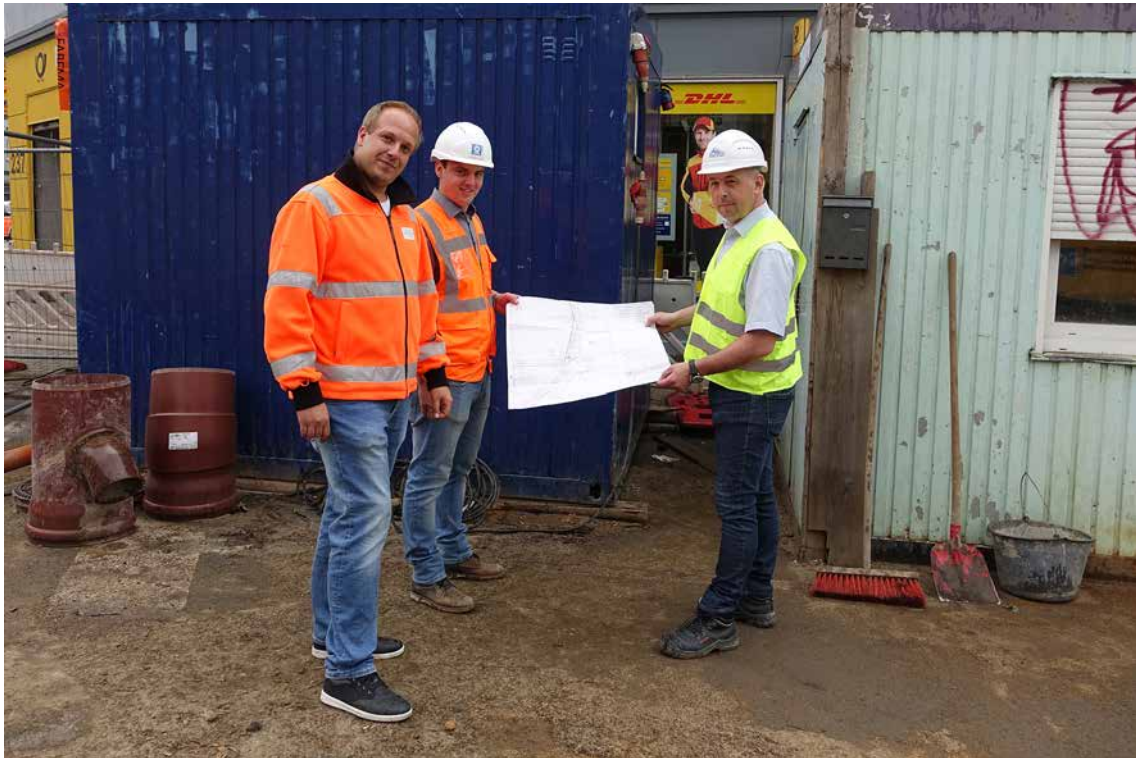
Arbeiteten gut zusammen (v.l.n.r.): Christian Paschen, Tiefbauamt der Stadt Bochum, Dirk Müller, Weitz & Co GmbH und Funke-Fachberater Ralf Börmann.
