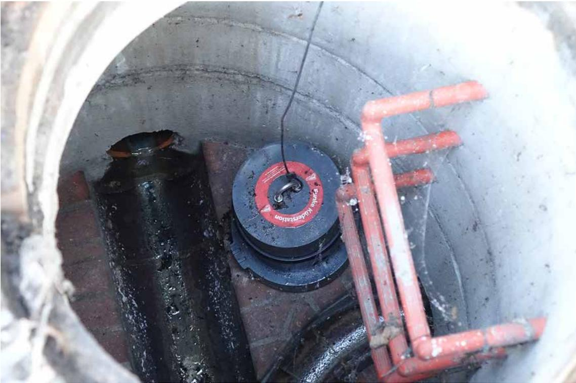
Die Funke Köderstation wurde fachgerecht auf der Zulaufseite im Schacht abgestellt. Beim Produkttyp 2 sorgt ein Sicherheitsseil dafür, dass die Köderstation von der Oberfläche aus eingesetzt werden kann.
