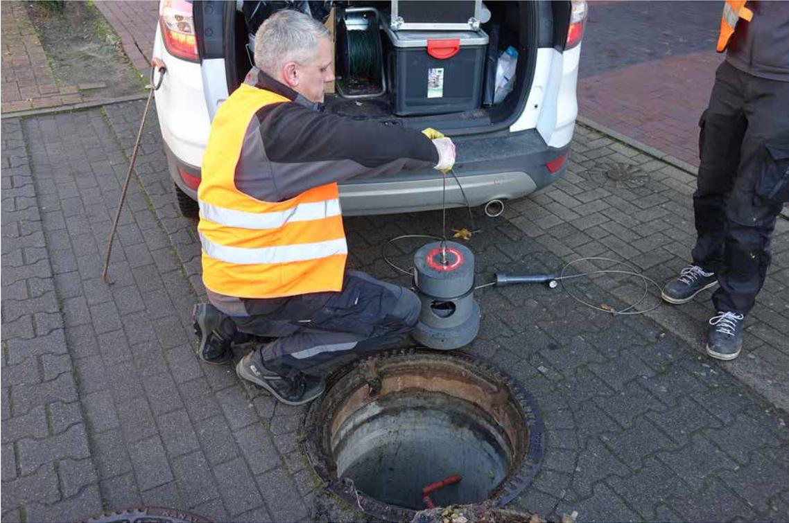
Ganz einfach von der Straße aus kann die Funke Köderstation in den Schacht abgelassen werden.
