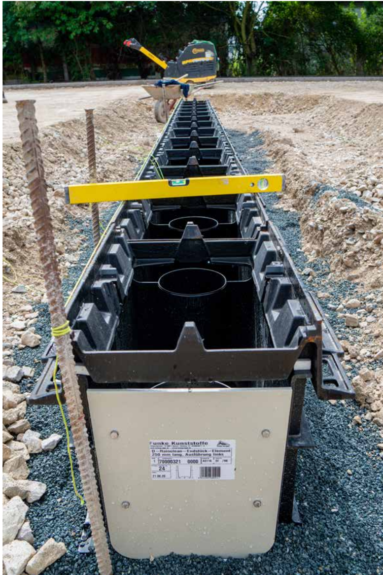
Fachgerechte Montage der D-Rainclean®-Sickermulde.
