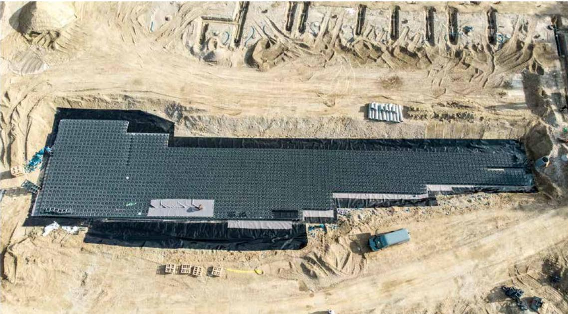
Mit dem D-Raintank 3000® auf der sicheren Seite: Die Speicherfähigkeit des Systems liegt bei 97%, während eine übliche Schotter- oder Kiesrigole nur ungefähr 30% bis 35% erreicht.
