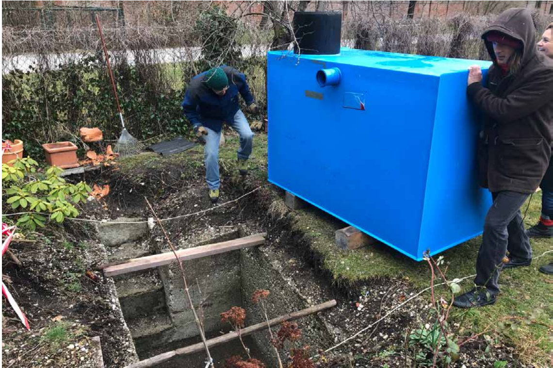
Einbau der KS-Bluebox®.
