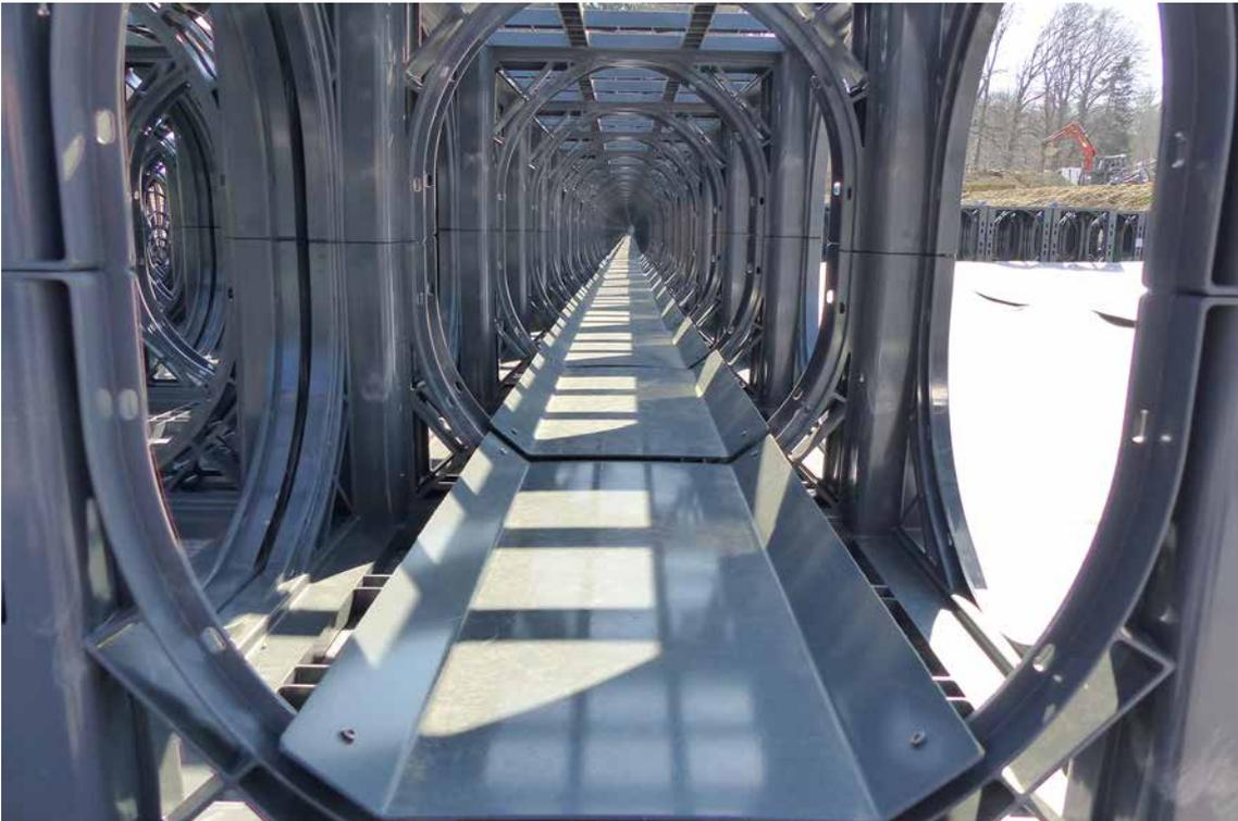
Die Inspektionsblöcke sind mit einer Schiene ausgestattet, die auch den Einsatz von Fahrzeugkameras mit kleinen Rädern ermöglicht.
