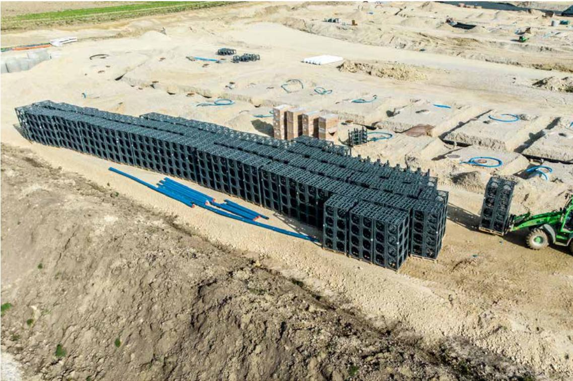
Die D-Raintank 3000®-Elemente werden auf Palette geliefert und können mit einem Gabelstapler bequem zur Einbaustelle gefahren werden.
