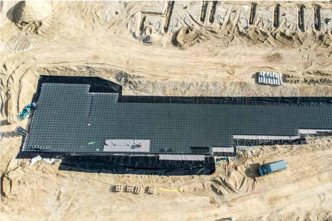
Mit dem D-Raintank 3000® auf der sicheren Seite: Die Speicherfähigkeit des Systems liegt bei 97%, während eine übliche Schotter- oder Kiesrigole nur ungefähr 30% bis 35% erreicht.
