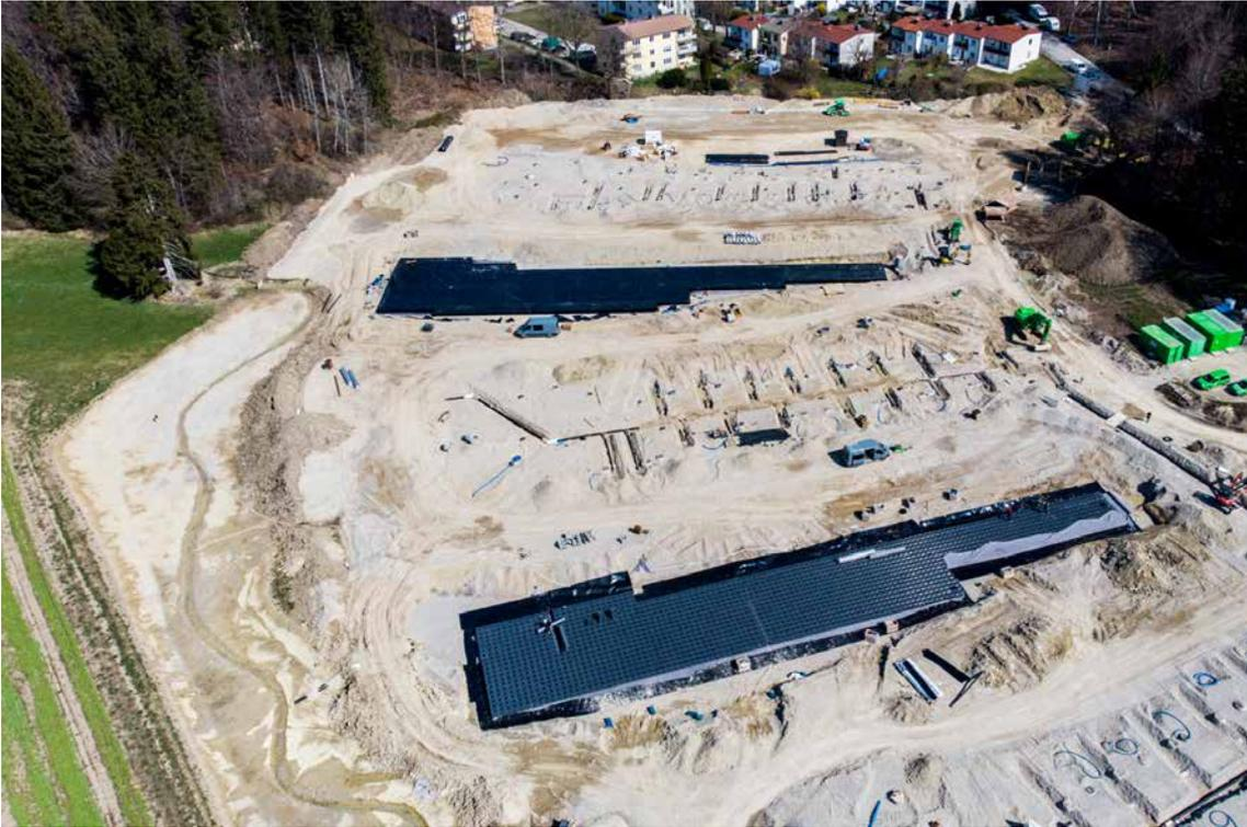
Regenwassermanagement in einer neuen Dimension: Zwei Rigolenkörper aus D-Raintank 3000®-Elementen sorgen im Baugebiet „Am Wiesengrund“ für eine gezielte Sammlung und Ableitung des anfallenden Niederschlagswassers.
