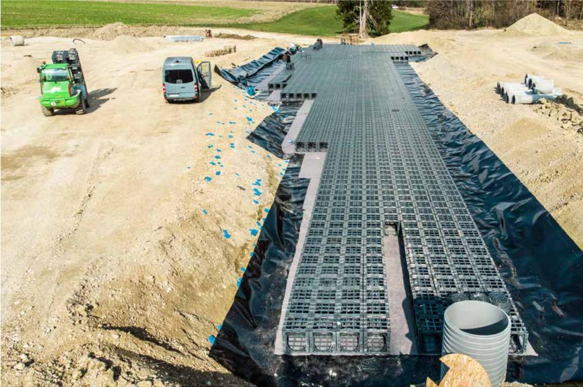
Im Zulaufbereich ist den Rigolen jeweils ein Sedimentationsschacht vorgeschaltet.
