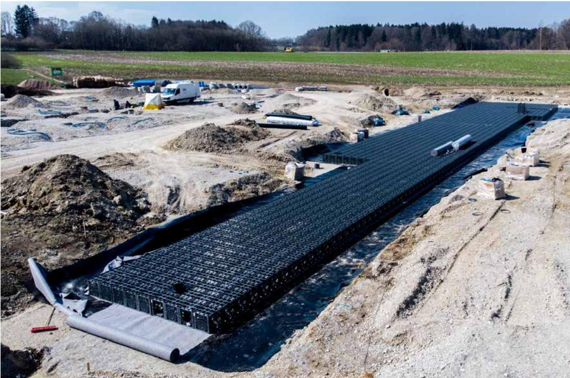
Bei der Nutzung als Speicherraum wird der Rigolenkörper zuerst mit einem Filtervlies, dann mit einer Folie eingeschweißt und abschließend noch einmal mit einem Filtervlies ummantelt.
