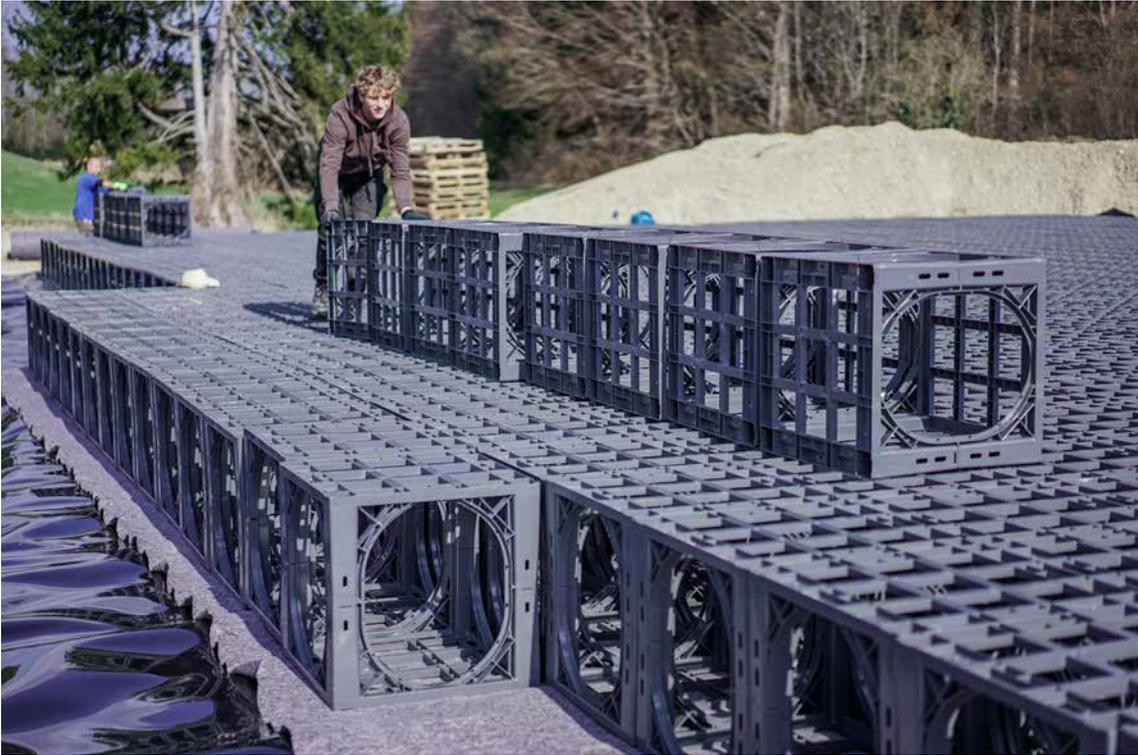
Ein D-Raintank 3000®-Element hat die Abmessungen 600 x 600 x 600 mm und ist an der Einbaustelle leicht zu handhaben.
