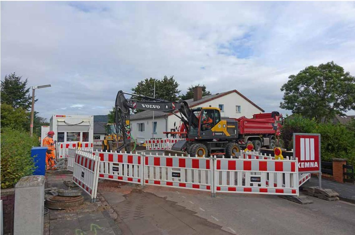
Zuviel Fremdwasser: Für die Erneuerung der Abwasserkanalisation im Bereich „Lütjes Feld“ in Schnedinghausen kamen Rohre und Formteile von Funke zum Einsatz.
