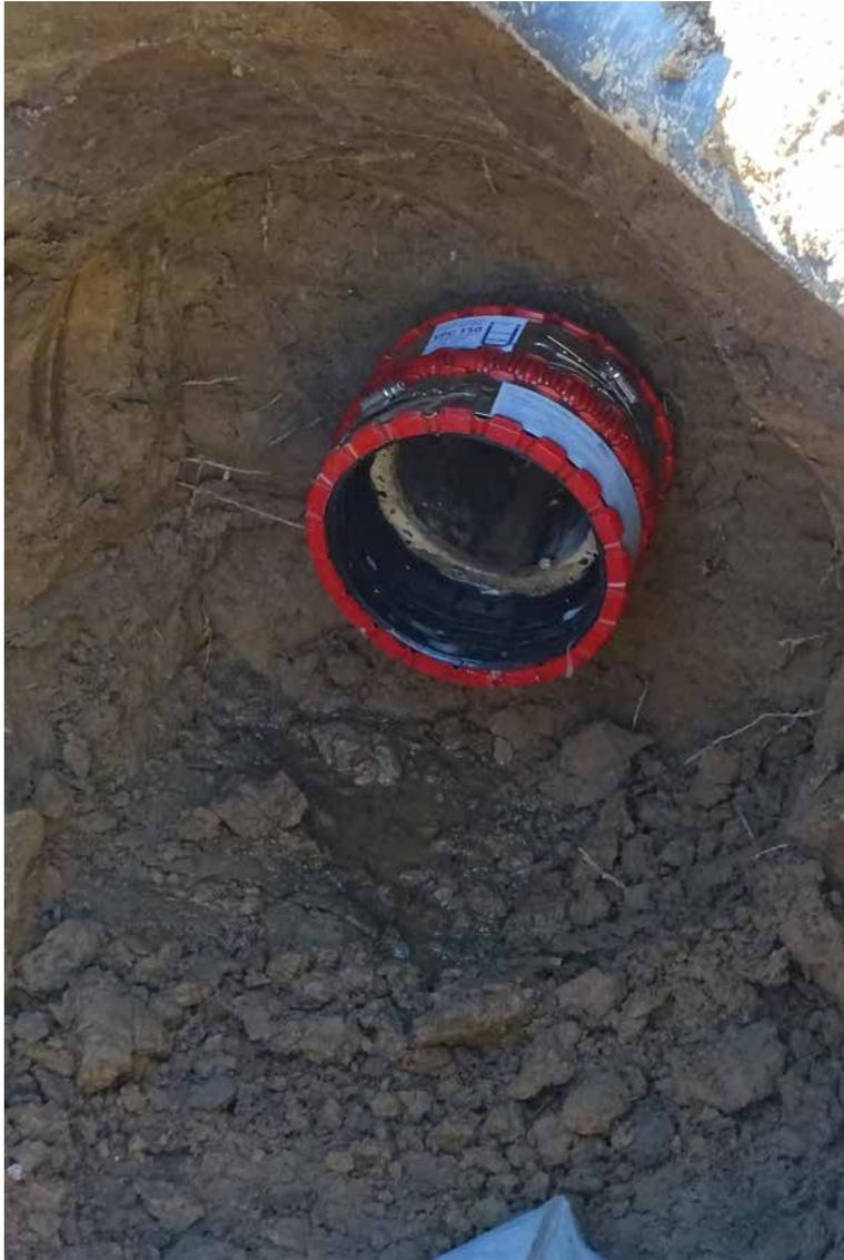
Ein Vorteil der VPC<sup>®</sup>-Rohrkupplung ist, dass sich mit ihrer Hilfe Rohre der gleichen Nennweite, aber aus verschiedenen Werkstoffen, trotz bauartbedingt verschiedener Außendurchmesser sicher miteinander verbinden lassen.
