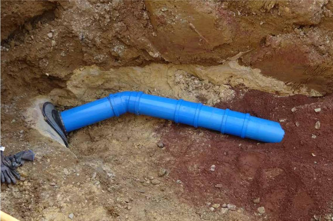
An den Stellen, wo die Bohrlöcher in den bestehenden, biegesteifen Sammlern Beschädigungen aufwiesen, konnte der Sanierungsstutzen von Funke die Voraussetzungen für einen sicheren Anschluss der Hausanschlussleitungen schaffen.
