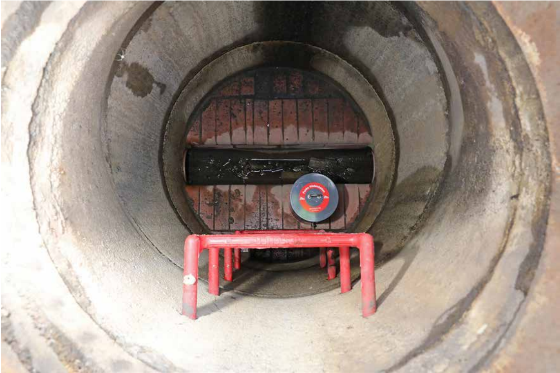
Sicherer Stand: Fachgerecht auf der Berme befestigte Köderstation.
