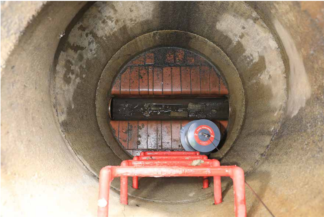
Auf der Berme aufgestellte Köderstation Typ 2.
