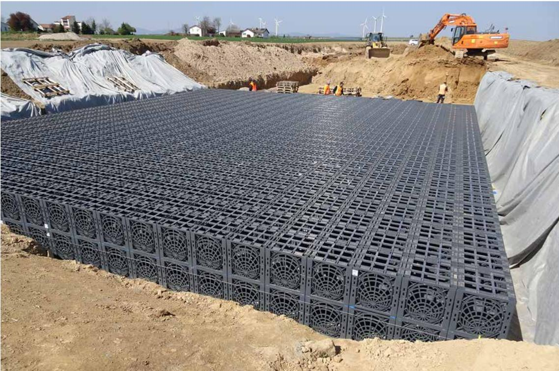
Beeindruckende Abmessungen: Die Rigolenfläche misst 93 x 15 m. Insgesamt 7.750 D-Raintank 3000®-Elemente kommen im Neubaugebiet in Herxheim zum Einsatz.
