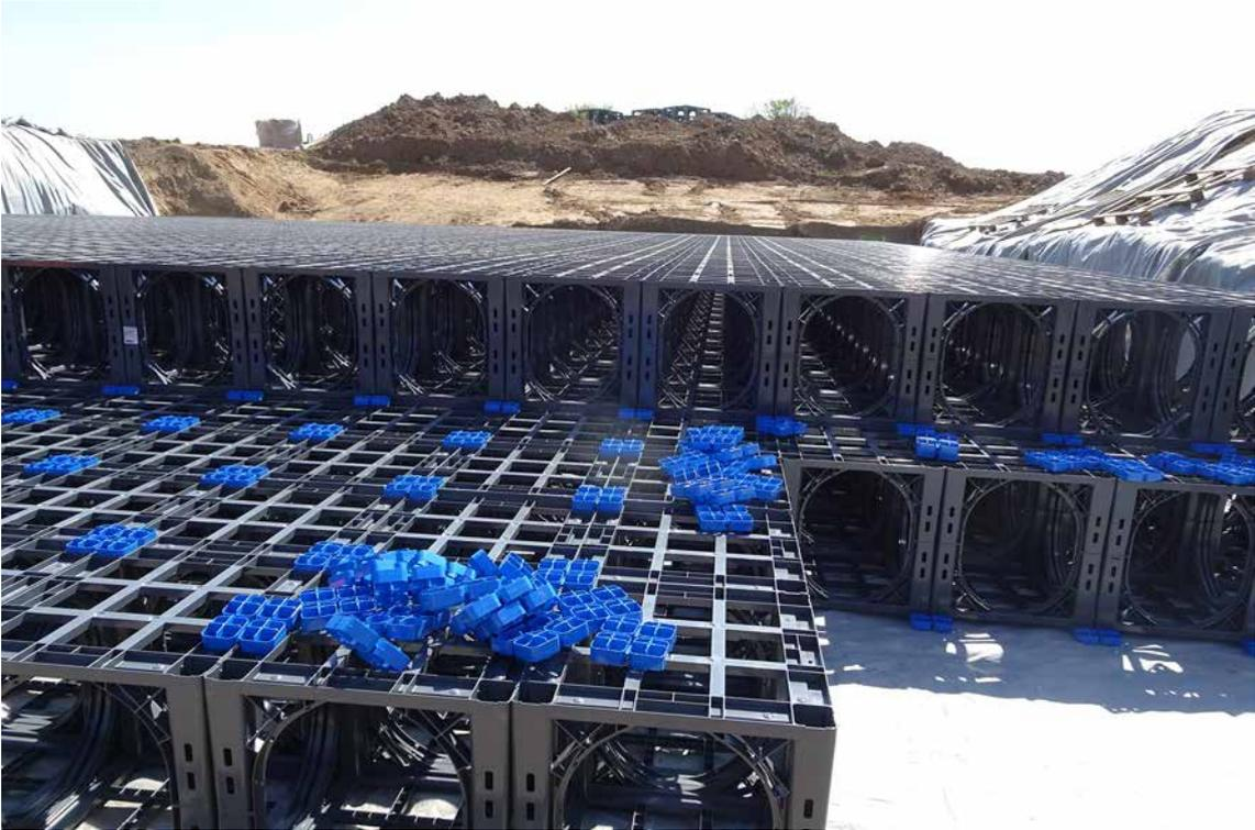
Im Inneren der Rigole sind keine Seitenplatten erforderlich. Dadurch sind Kamera-Befahrungen und Inspektionen in alle Richtungen möglich.
