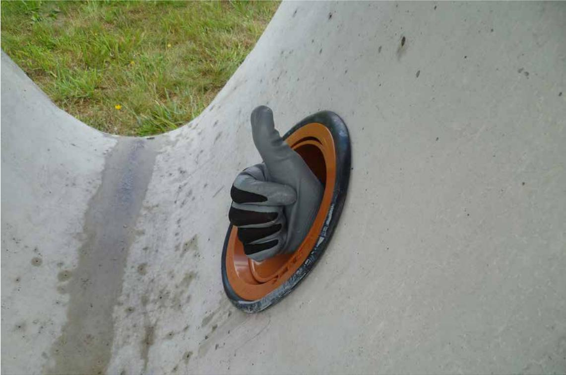
Mit seiner flexibel gelagerten Dichtung ist der U3-Anschluss nach der fachgerechten Montage formschlüssig mit dem Sammler verbunden.
