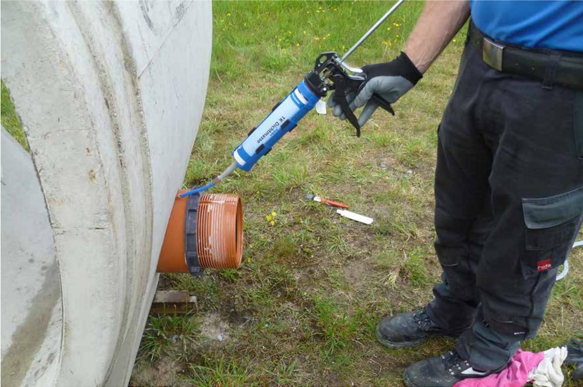
Das abschließende Einpressen der Funke 1 K-Dichtmasse in das Bauteil sorgt zusätzlich für einen festen Sitz.
