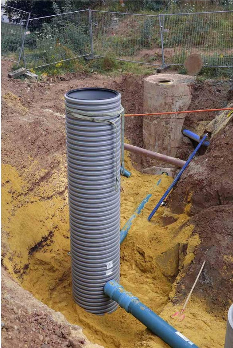
Das in den KS-Bluebox®-Elementen gesammelte Niederschlagswasser gelangt in den Drosselschacht von Funke und wird von hier sukzessive in die Kanalisation abgegeben.
