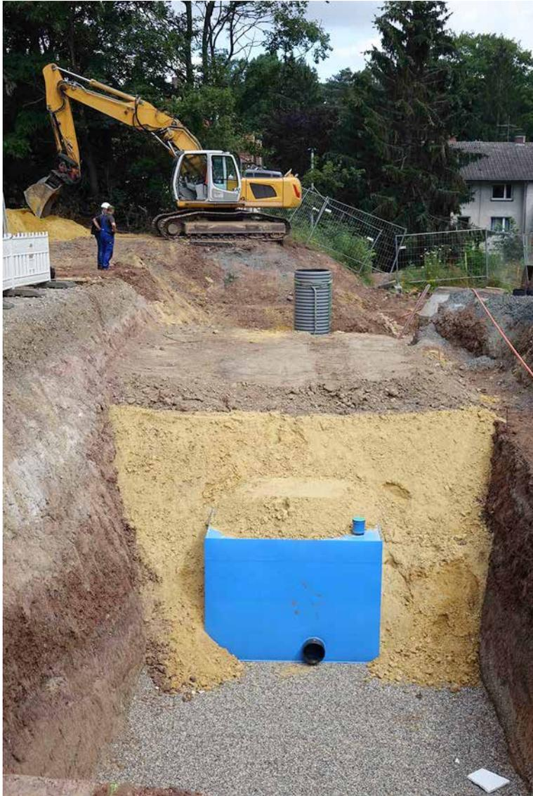
In einer zweiten kleineren Regenrückhalteanlage wurden zwei KS-Bluebox®-Elemente hintereinandergeschaltet.
