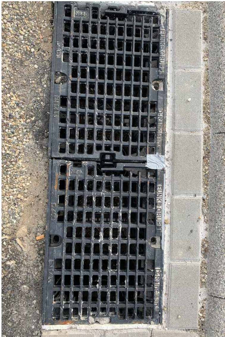
Die D-Rainclean®-Sickersmulde mit Gussabdeckung Klasse D 400.
