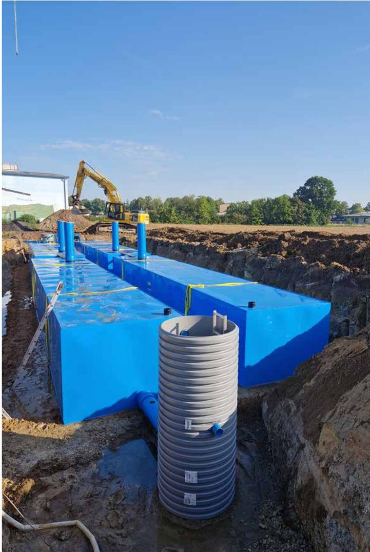
Die vier KS-Bluebox®-Elemente sind jeweils mit einem Inspektionsblock DN/OD 400 und einem Entlüftungsanschluss ausgestattet.
