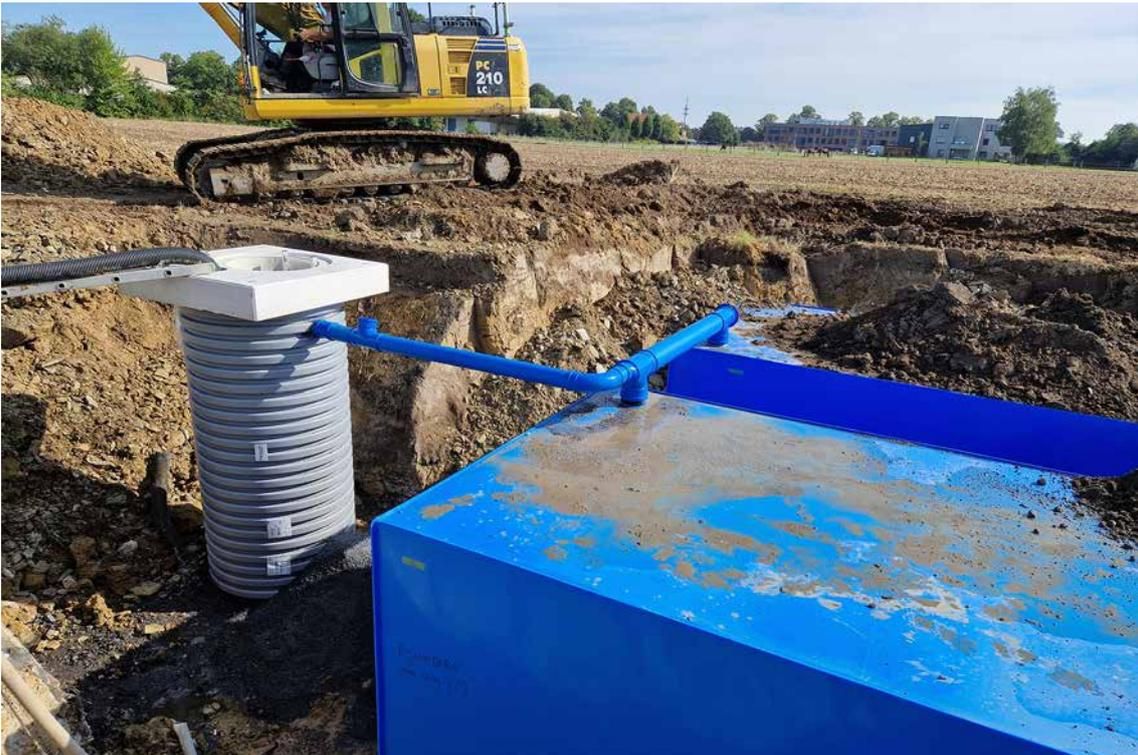
Die Entlüftung der KS-Bluebox®-Elemente und der Funke Entnahmeschächte DN/ID 1000 erfolgt über separate Entlüftungsrohre.
