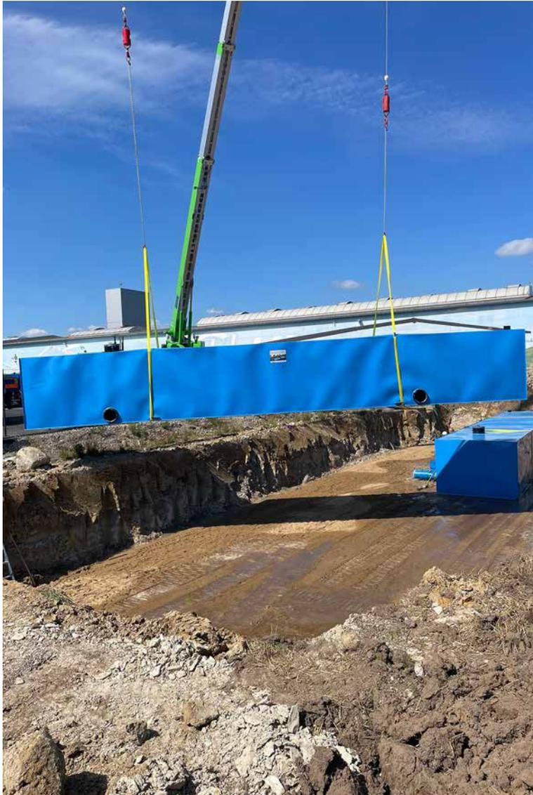
Einsetzen der KS-Bluebox®-Elemente mittels Alu-Kran.
