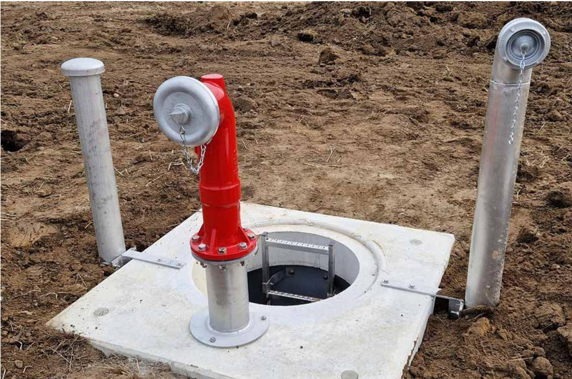
Die Löschwasserentnahmestelle wurde zusätzlich mit einem B-Storz-Anschluss zur Befüllung (r.) ausgestattet. Links ist die Entlüftung, mittig der A-Storz-Anschluss zur Entnahme zu sehen.
