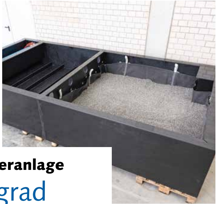
Einbau des AreaClean Filtersubstrats
