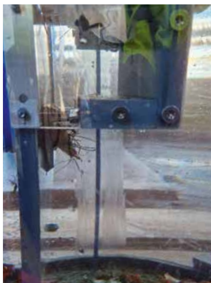
Abreinigungsvorgang einer stark verschmutzten Drosselöffnung
