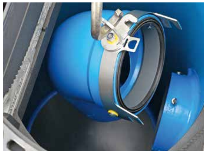
Die Verschlusslasche wird um mindestens 45° verdreht, und schon kann das Einbauteil entnommen werden
