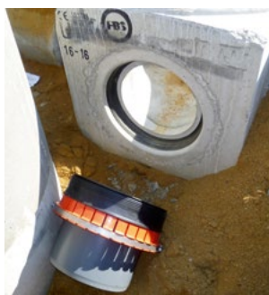
Einstecken des BSM-Adapters in die Schachtmuffe
