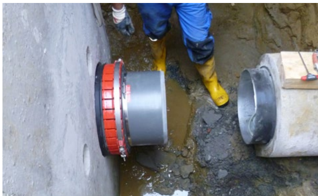
Montage eines Kanalrohres an den BSM-Adapter®
