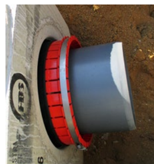
Einstecken des BSM-Adapters in die Schachtmuffe
