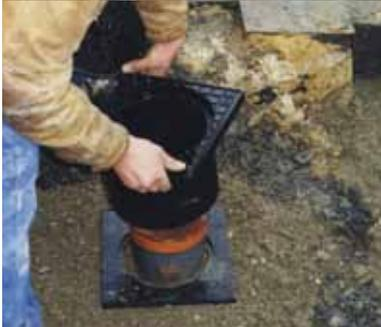
Beim Aufsetzen der Gussabdeckung müssen die Zapfen des Teleskoprohres durch die Aussparungen der Gussabdeckung geführt werden.
