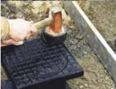
Nachdem die HS-Abwasserkontrolle fertig eingebaut wurde, müssen die Schrauben der Gussabdeckung Klasse D 400 z. B. mit dem Vierkantschlüssel durch Rechtsdrehung mit 100 Nm angezogen werden.
