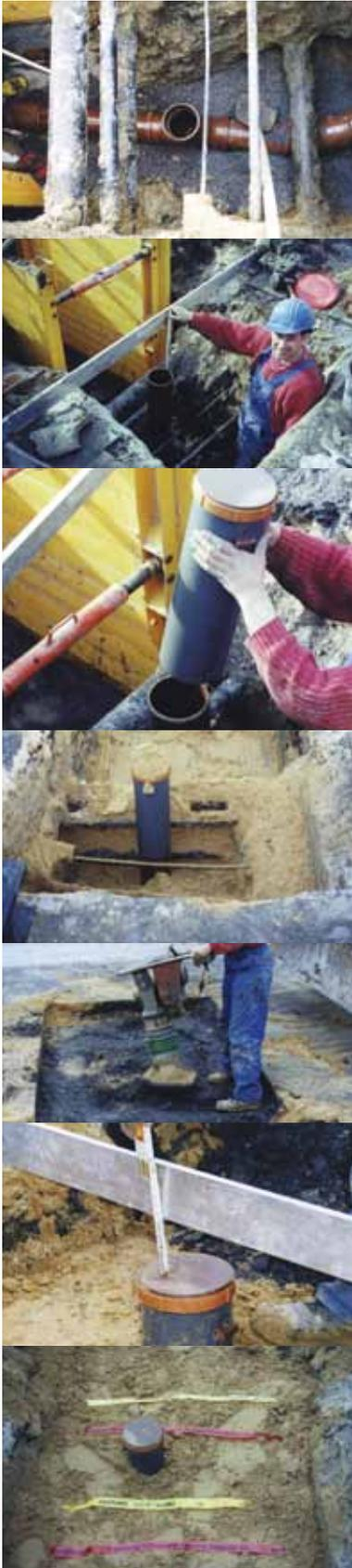
Der HS-Abzweig K 90 wird auf einem fachgerecht erstellten Planum auf der Grabensohle eingebaut. Als Material empfehlen wir Splitt, Schotter oder Kies in der Korngröße 0-32 mm. Innerstädtische Einbausituationen mit vielen kreuzenden Leitungen erfordern ein genaues Einmessen und Setzen des Abzweiges.
