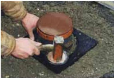
Bitte die Einbauhöhe des Teleskoprohres kontrollieren (Abstand 12 cm!) und danach die Tragplatte einbauen.
