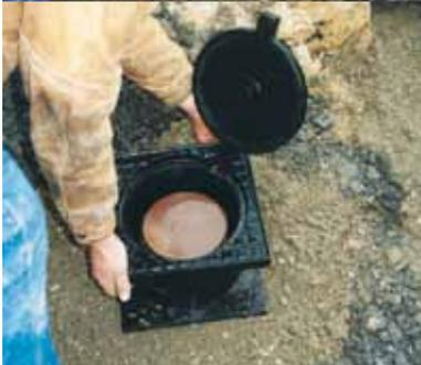
Nach dem Drehen um 90° nach rechts oder links wird die Gussabdeckung parallel zur Pflasterichtung (Gehwegplatte) ausgerichtet, um eine saubere Einarbeitung des Bauteils sicher zu stellen.
