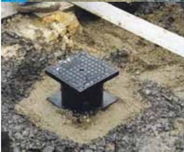
Beim Einbau der HS-Abwasserkontrolle in Einfahrten ist die Gussabdeckung dem gegebenen Neigungswinkel einfach anzupassen. Durch das quadratische Format (300 x 300 mm) fügt sie sich harmonisch in Pflaster, Gehwege, Einfahrten und andere Oberflächen ein.
