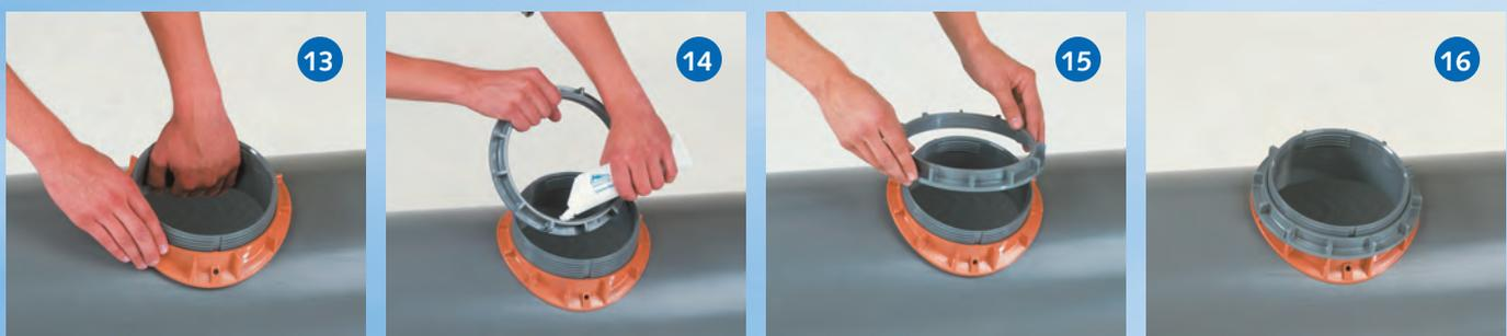
**Wichtig: Unterteil in Bohröffnung so zentrieren, dass umlaufend ein gleichmäßiger Ringspalt entsteht! (13).** Graues Gewinderad innen mit dazugehörigem Gleitmittel bestreichen (14). Graues Gewinderad so aufsetzen, dass es nicht verkantet, sondern sich leicht verschrauben lässt (15). Mit einer Hand Anschlussunterteil hochziehen, um es an den Innenradius des Hauptrohres anzupassen. Mit der anderen Hand graues Gewinderad handfest verschrauben (16).
