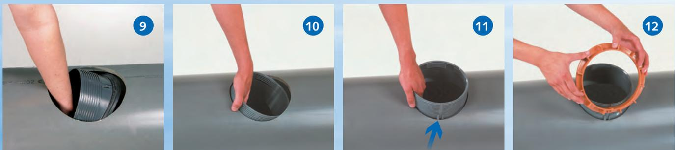
CONNEX-Anschluss im Rohr drehen und dem Rohrradius entsprechend hochziehen (10), bis Halteclips (siehe Pfeil) (11) ausklappen, um den Anschluss zu fixieren. Rotbraunen Distanzring auf Führungsnut des Unterteils aufsetzen (12).
