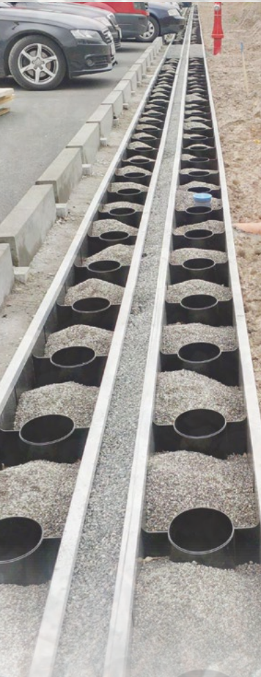
Abb. 1: D-Rainclean®-Sickersmulde ohne Gussabdeckung (offen)
